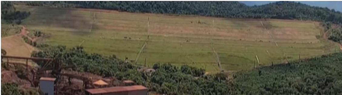
Figura 1 – Vista Frontal da barragem no início da ruptura (embaixo, lado direito).
