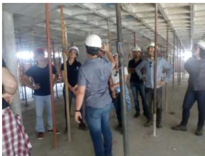
Figura 12 – Visita técnica realizada na obra para estudar laje protendida
