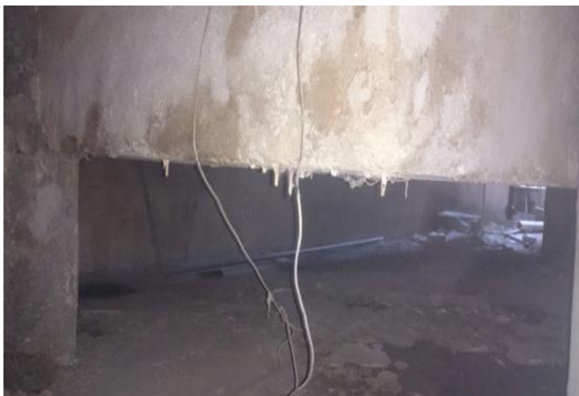
Figura 17: manifestação patológica da lixiviação.
