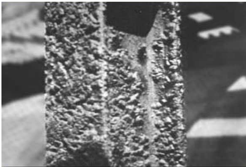
Figura 10: Esfoliação em peça metálica.
