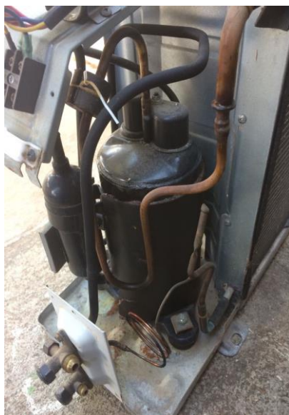
Figura 3 - Unidade condensadora desmontada
