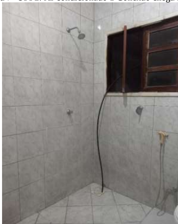
Figura 7- OPP2: Ar condicionado 1 Conexão chega ao ralo
