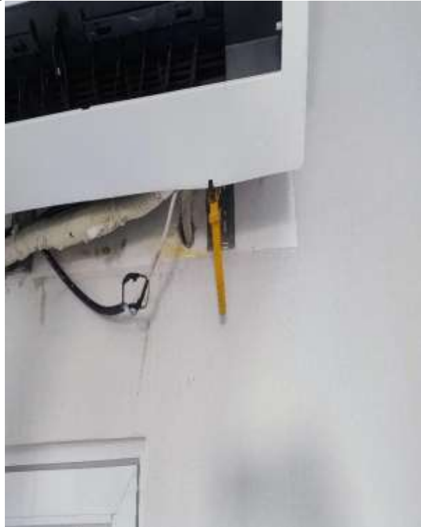
Figura 14 - OPP6: Ar condicionado 1 Dreno instalado
