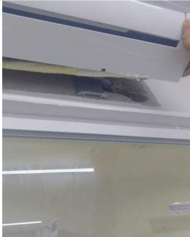
Figura 15 - OPP6: Ar condicionado 2 Dreno instalado
