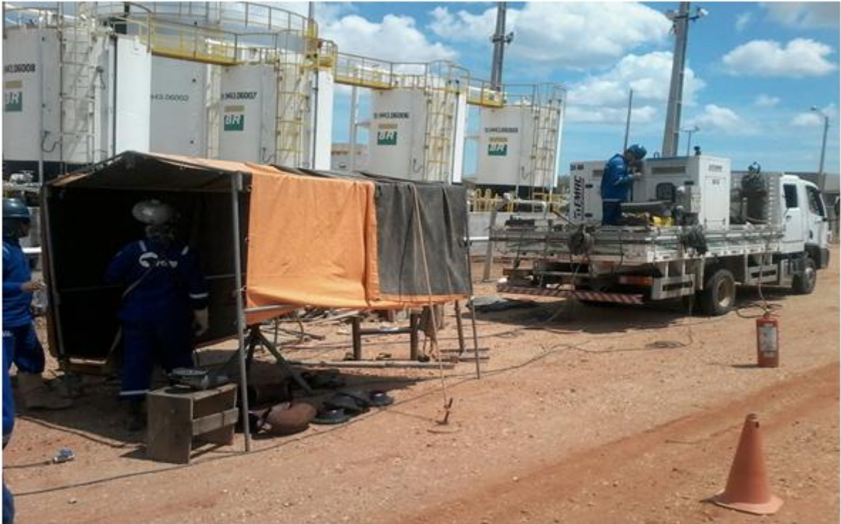
Figura 10. Soldagem de tubulação em campo.
