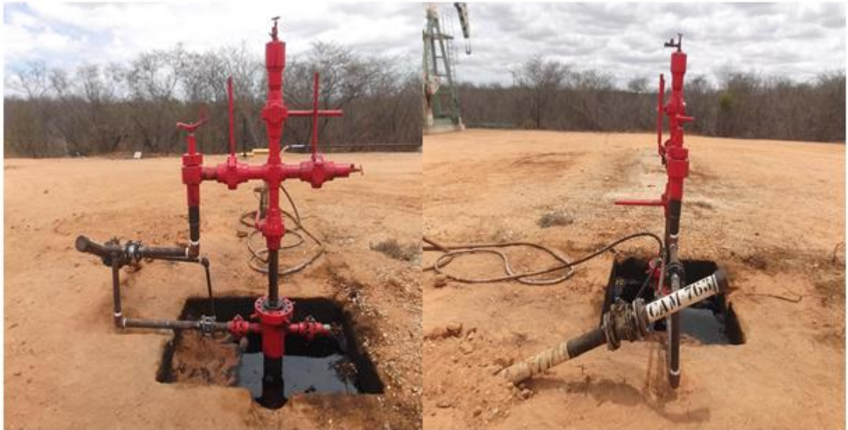
Figura 5. Montagem interligando a cabeça do poço produtor de óleo com a tubulação de aço.
