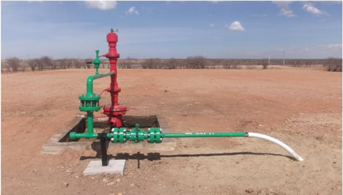
Figura 6. Montagem interligando a cabeça do poço injetor de água com a tubulação de fibra de vidro.
