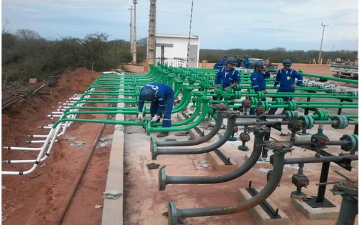
Figura 7. Montagem de satélite injetor de água.
