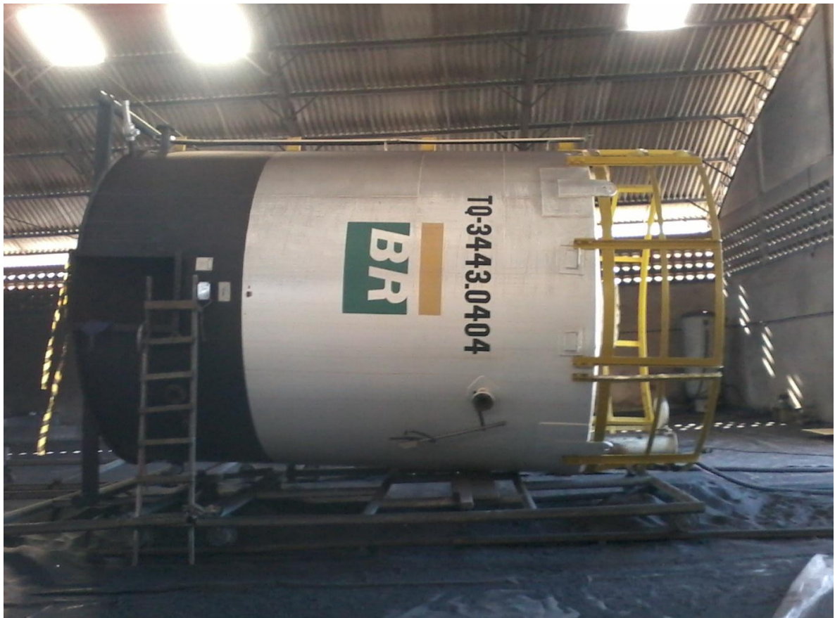
Figura 4: Pintura de tanques por jateamento.
