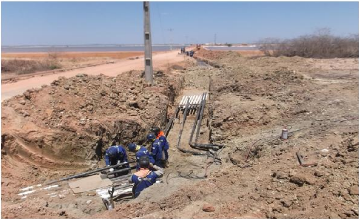
Figura 9. Substituição das linhas de tubos de aço por linhas de tubos revestidos de poliuretano.
