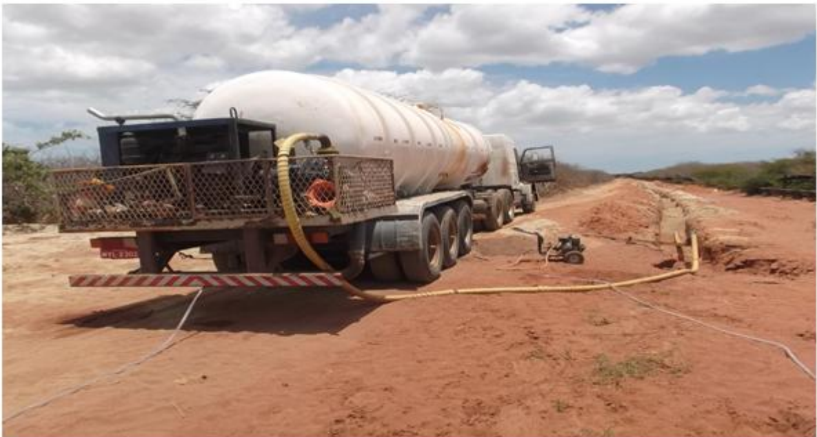
Figura 8. Operacionalização de teste hidrostático em linhas de fibra de vidro.
