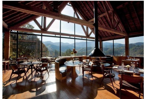
Figura 103 - Tesouras e Vigas em Madeira.
