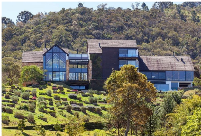
Figura 98 - Fachada Bloco Principal Botanique.
