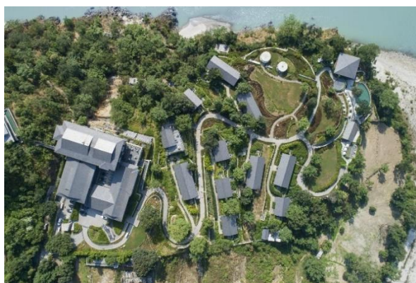
Figura 48 - Vista Superior do Taj Rishikesh.
