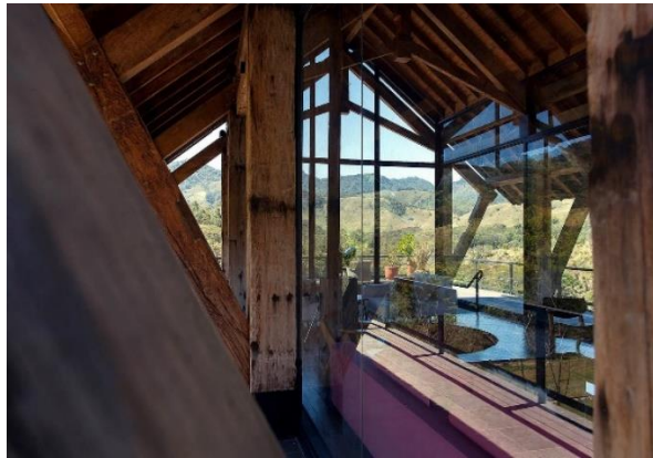
Figura 102 - Pilares em Madeira Botanique.
