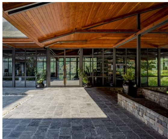
Figura 56 - Parte Externa Taj Rishikesh.
