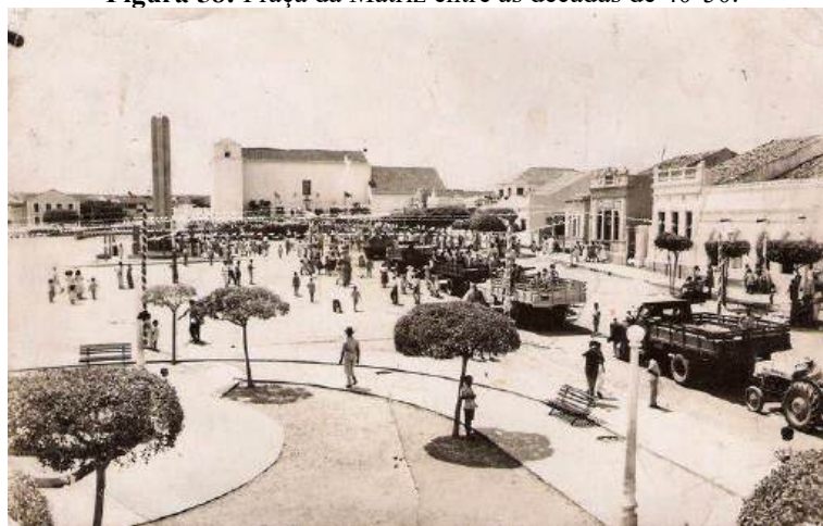
Figura 58: Praça da Matriz entre as décadas de 40-50.
