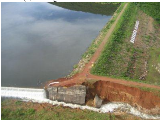
(e) Barragem de terra-enrocamento
