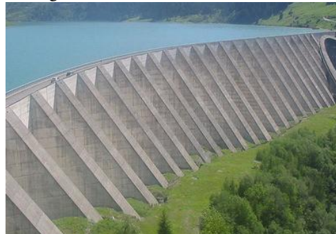
(b) Barragem de concreto estrutural com contrafortes
