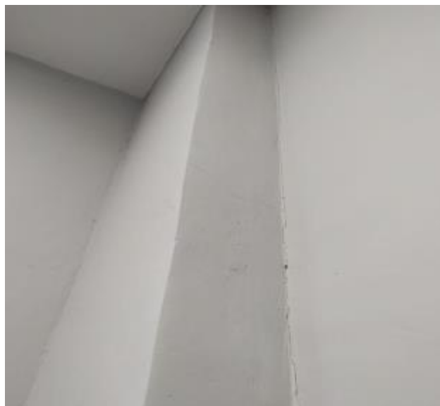
Figura 13- Fissura Vertical
