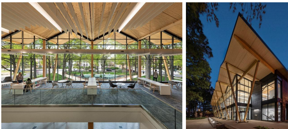
Figura 13: Marquise da fachada norte vista do interior/exterior
