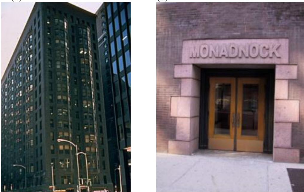
Figura 4: Edifício Monadnock, Chicago (1891). (a) Fachada mostrando os seus 16 pavimentos; (b) Paredes do pavimento térreo com 1,80m de largura.
