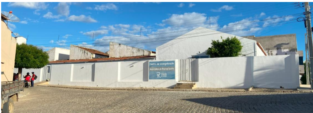
Figura 03: Fachada frontal da edificação.
