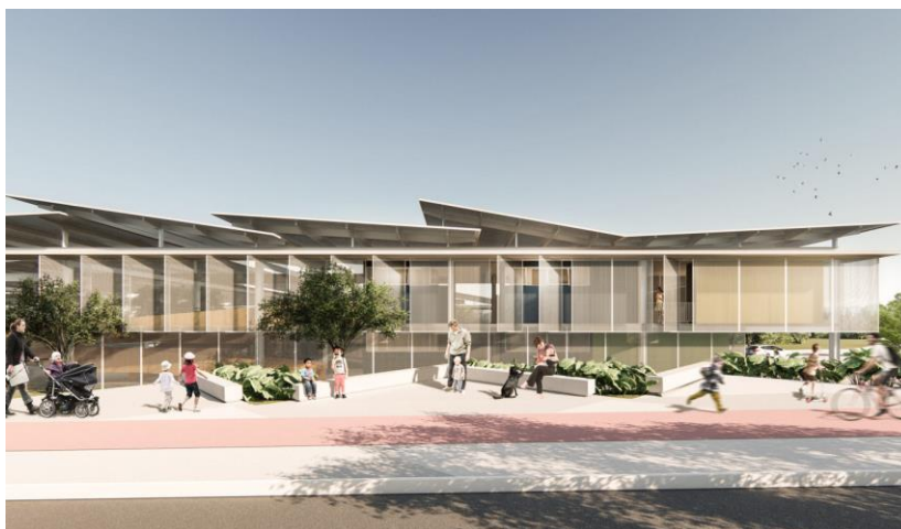
Figura 49: Cobertura metálica da Escola Classe.
