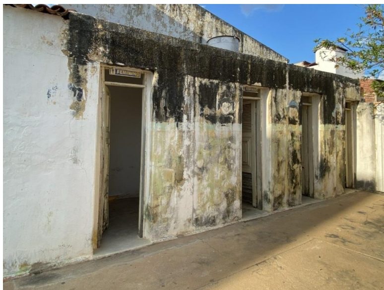
Figura 38: Acesso aos banheiros.
