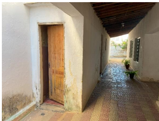
Figura 29: Acesso ao banheiro central.
