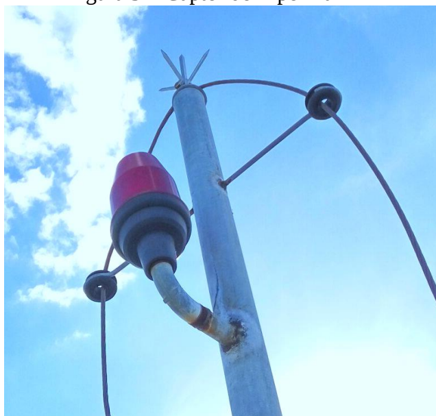
Figura 31- Captor do Tipo Franklin
