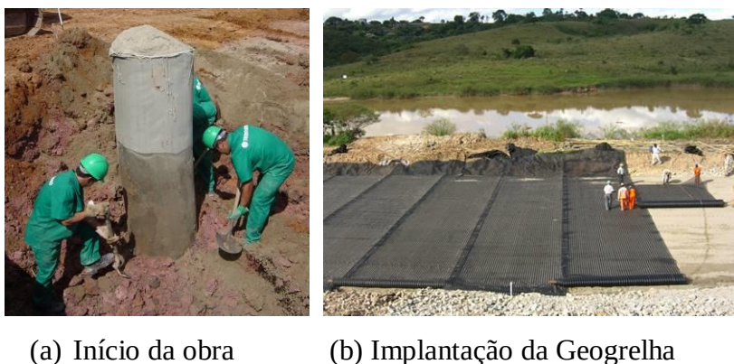
Figura 20 – Execução da Obra 3
