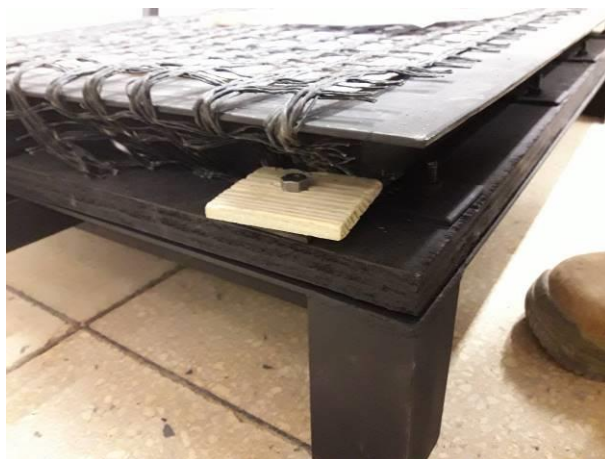
Figura 25 – Fixação da geogrelha.
