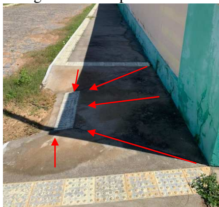
Figura 36: Rampas de acesso
