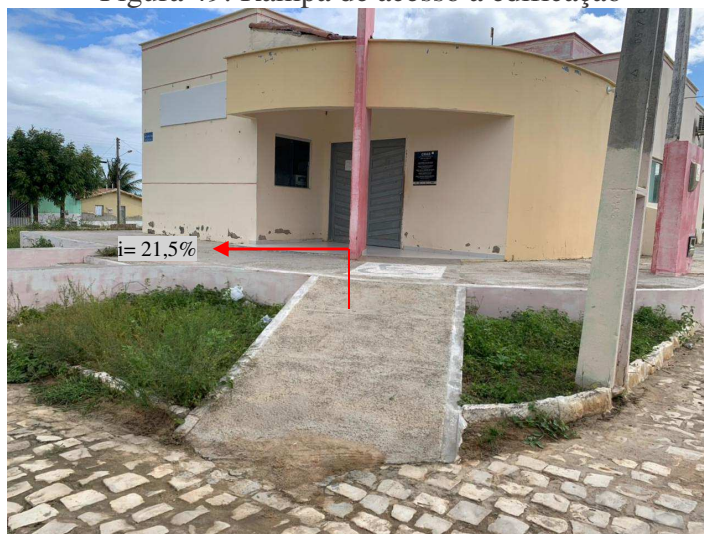
Figura 49: Rampa de acesso a edificação
