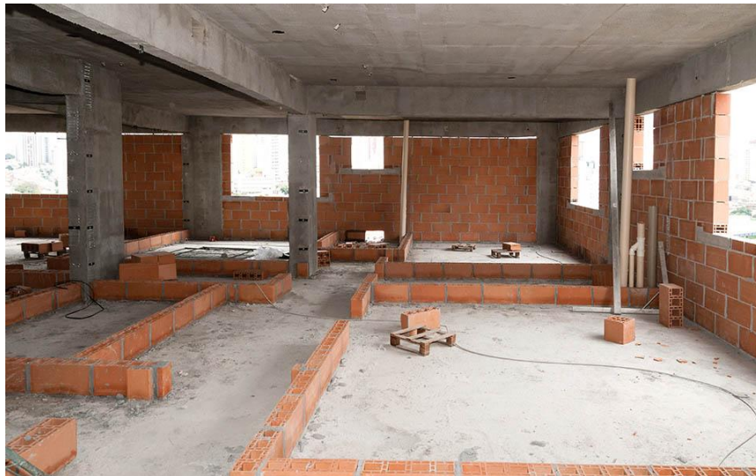
Figura 8 – Alvenaria de vedação. Fonte: Tecnisa Consultoria Imobiliária.
