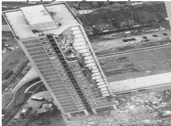
Figura 17 - Colapso progressivo gerado por explosão no edifício Ronan Point.
