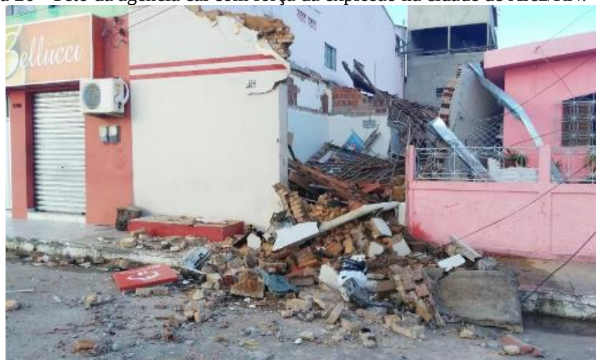
Figura 26 - Teto da agência cai com força da explosão na cidade de Arez/RN.
