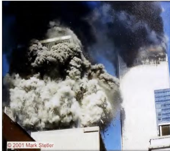
Figura 24 - Fotografia do WTC 2 inclinando-se para o sudeste no início do colapso.
