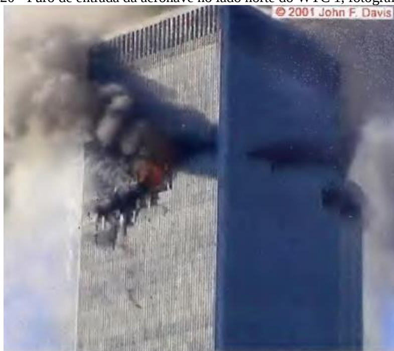
Figura 20 - Furo de entrada da aeronave no lado norte do WTC 1, fotografado 30 s.
