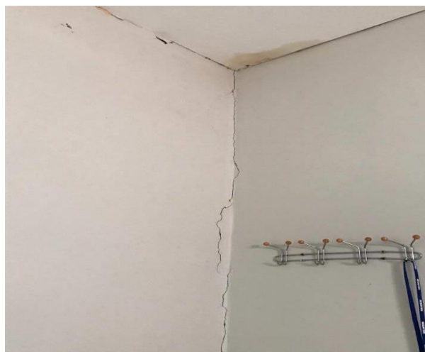
Figura 2 - Fissura Vertical em Pilar.
