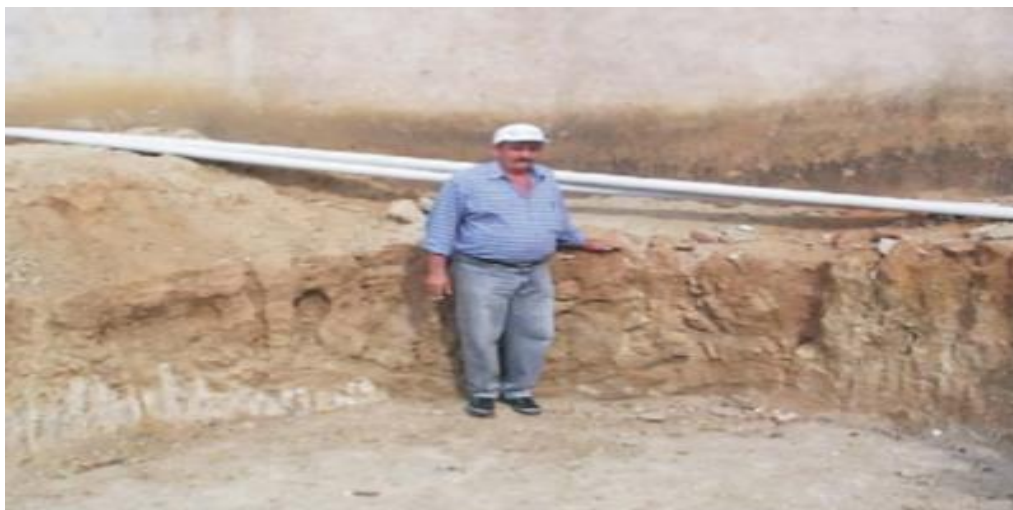
Figura 8: Escavação do Alicerce
