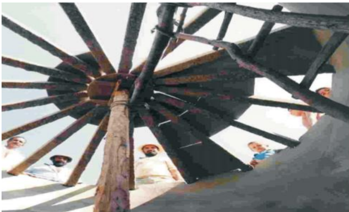
Figura 13: Montagem da tampa da cisterna
