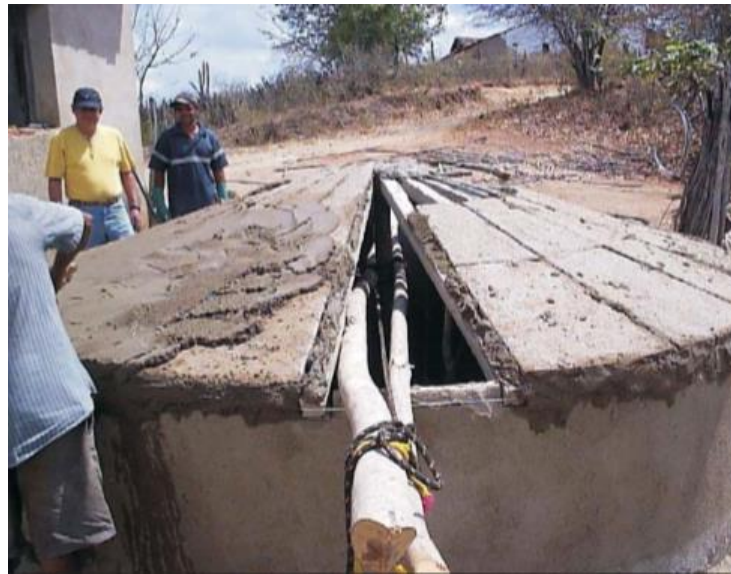
Figura 14: Detalhes da Montagem da Tampa da Cisterna
