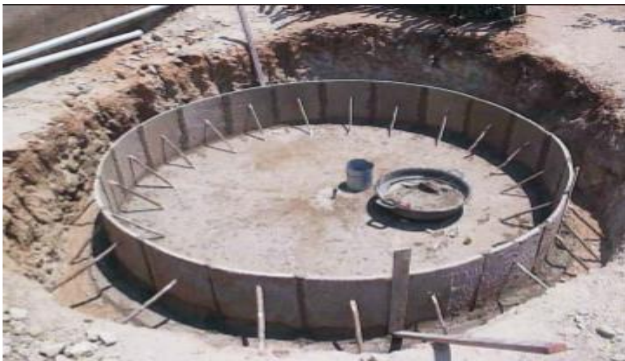
Figura 11: Montagem da primeira fileira
