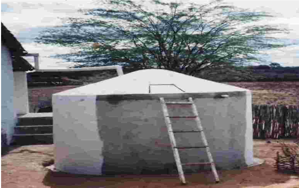
Figura 3: Cisterna de tela-cimento de 10 000 litros
