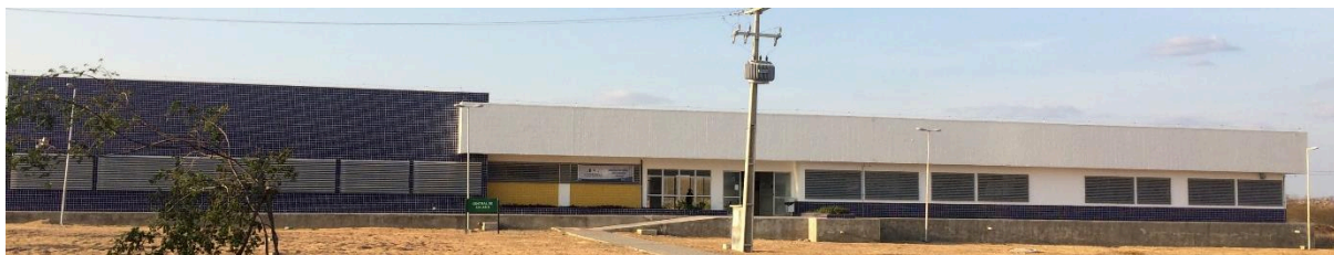
Figura 24 – Central de Aulas II
