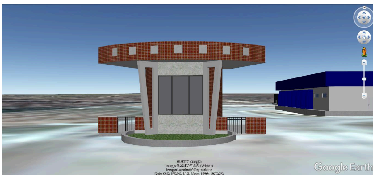
Figura 56 – Guarita vista no Google Earth
