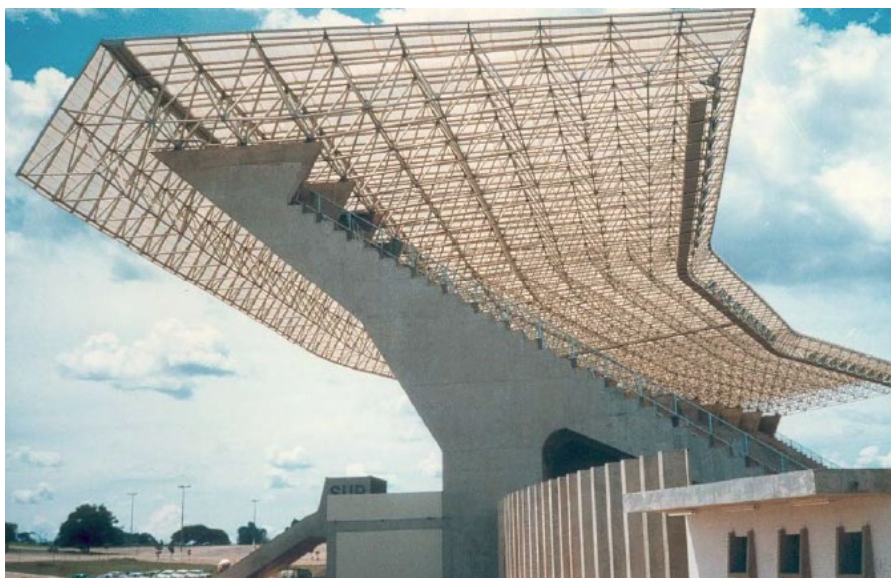
Figura 2- Cobertura do estádio Mané Garrincha com estrutura espacial
