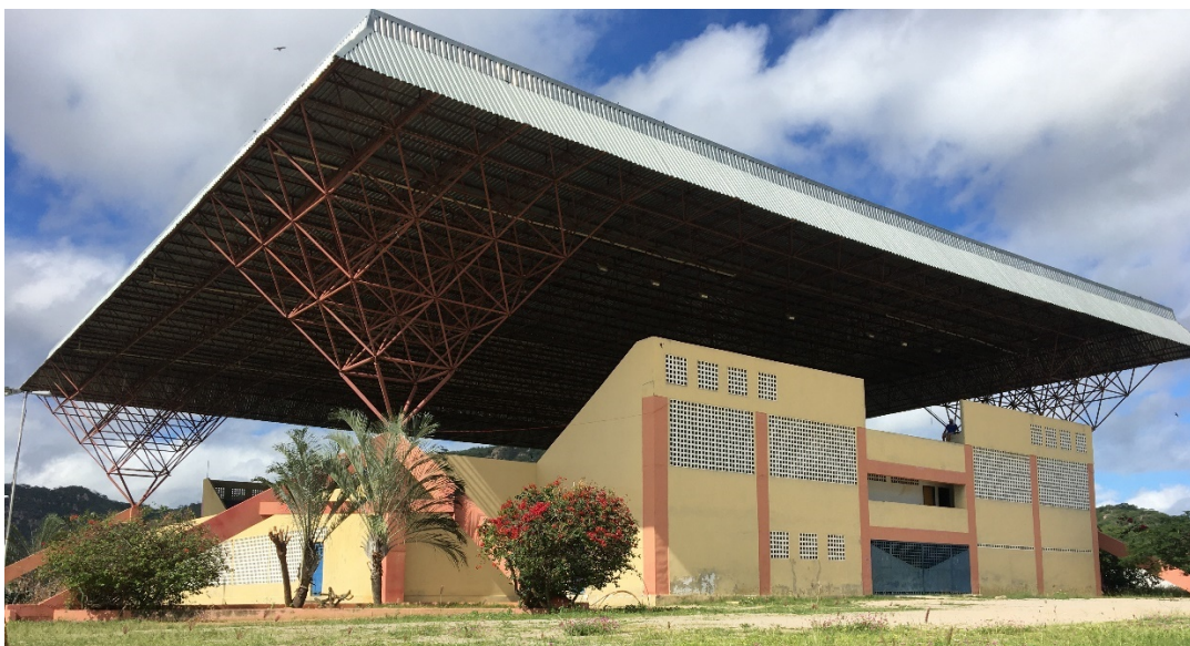
Figura 6 - Ginásio Poliesportivo Francisco Torres de Carvalho (Salgueiro-PE)
