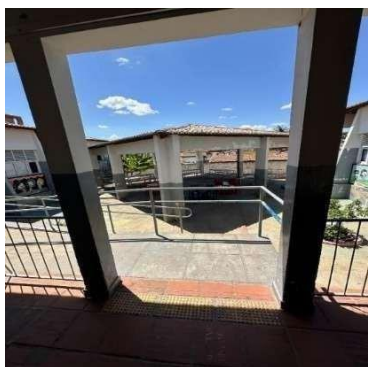
Figura 26 – Acesso a Rampa
