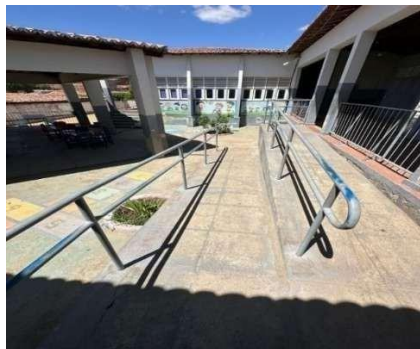
Figura 27 – Rampa com Corrimão
