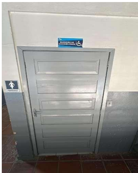
Figura 33 - Porta do banheiro acessível
