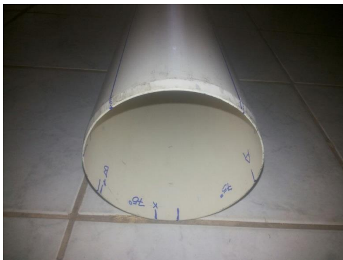
Figura 5.1.4 – Cano PVC devidamente marcado para os cortes.
