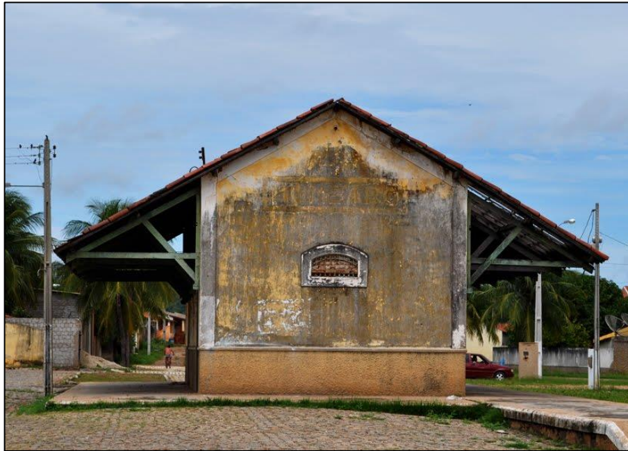
Figura 16: Estação Mineiro no ano de 2012
