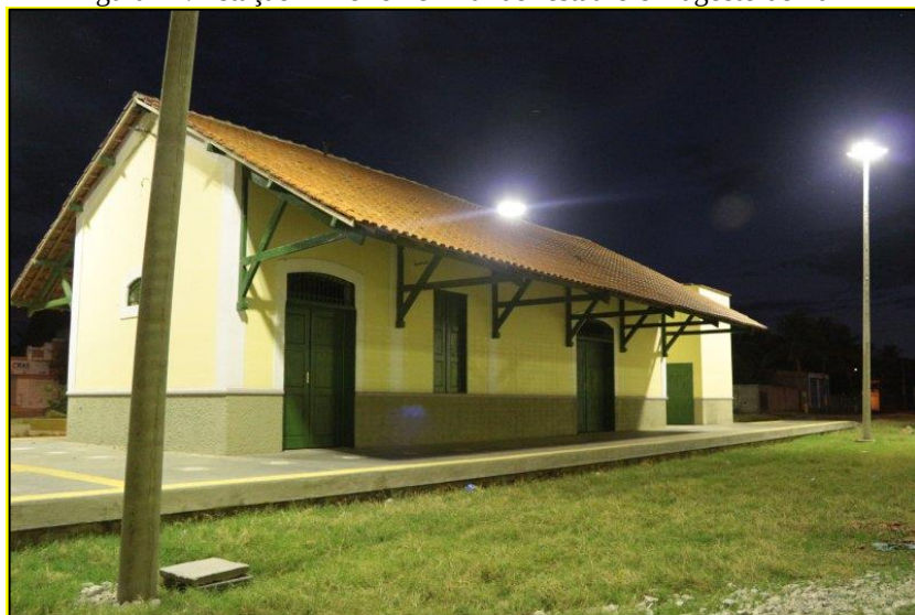
Figura 17: Estação Mineiro no final do restauro em agosto de 2014
