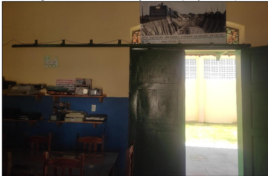
Figura 33: Detalhamento sobre a porta interna (Estação Mineiro)
