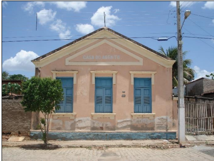
Figura 19: Casa do Agente antes da reforma
