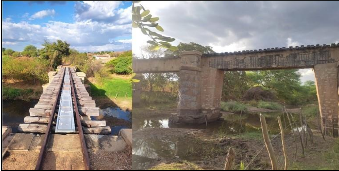
Figura 20: Ponte sobre o Rio Mineiro
