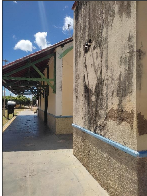
Figura 34: Detalhamento sobre área externa dos banheiros na Estação Mineiro
