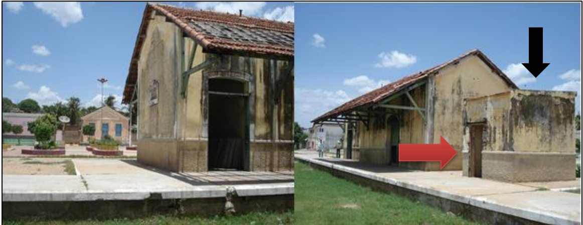
Figura 29: Estação Mineiro antes da reforma (2012)
