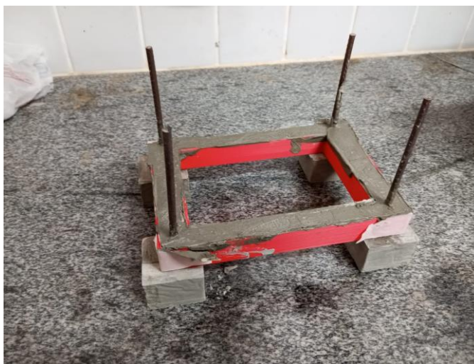
Figura 10 – Montagem e preenchimento das vigas baldrames.
