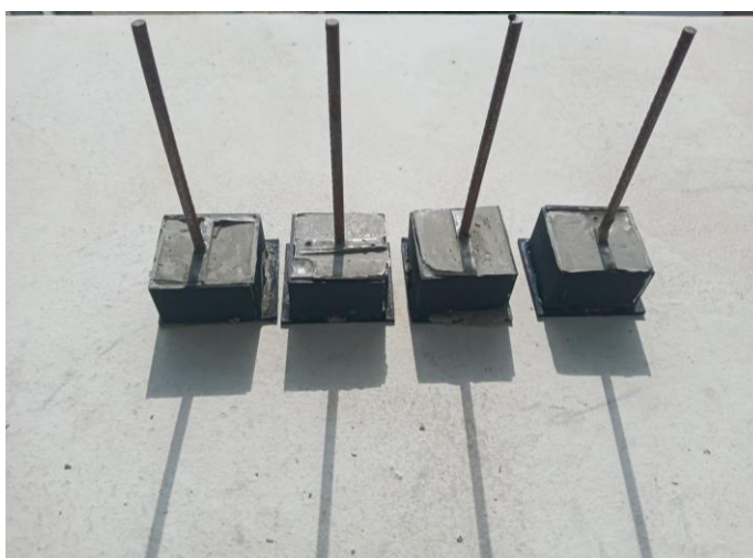
Figura 9 – Montagem e preenchimento dos blocos de fundação.
