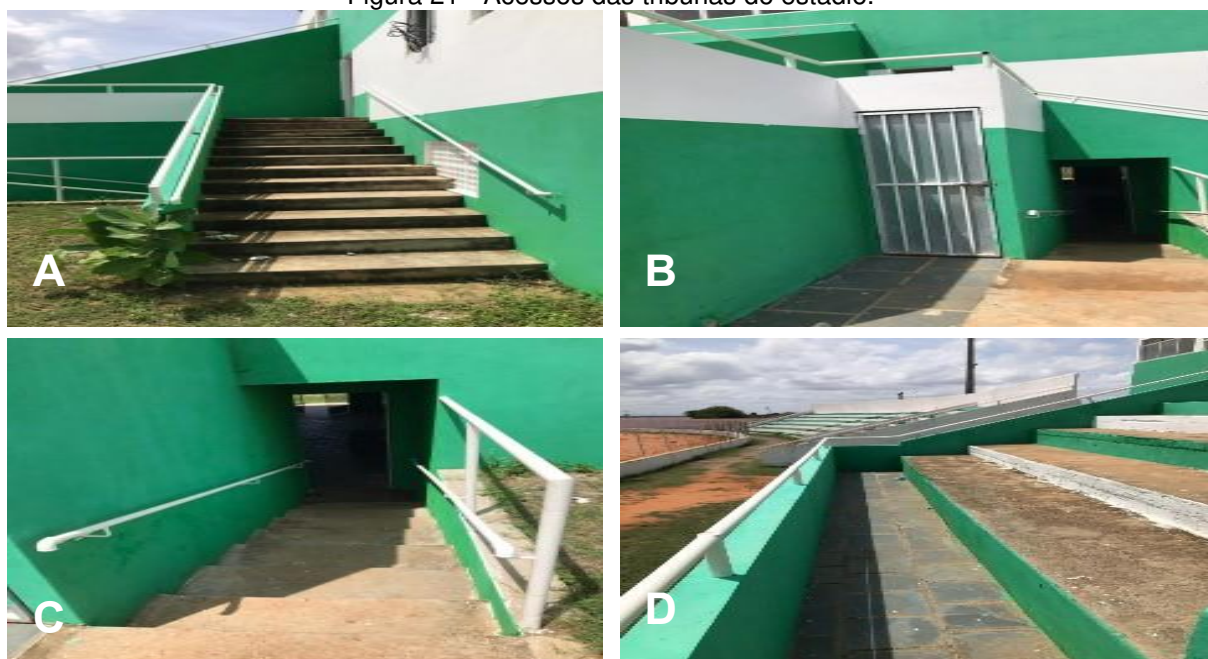
Figura 21 - Acessos das tribunas do estádio.
