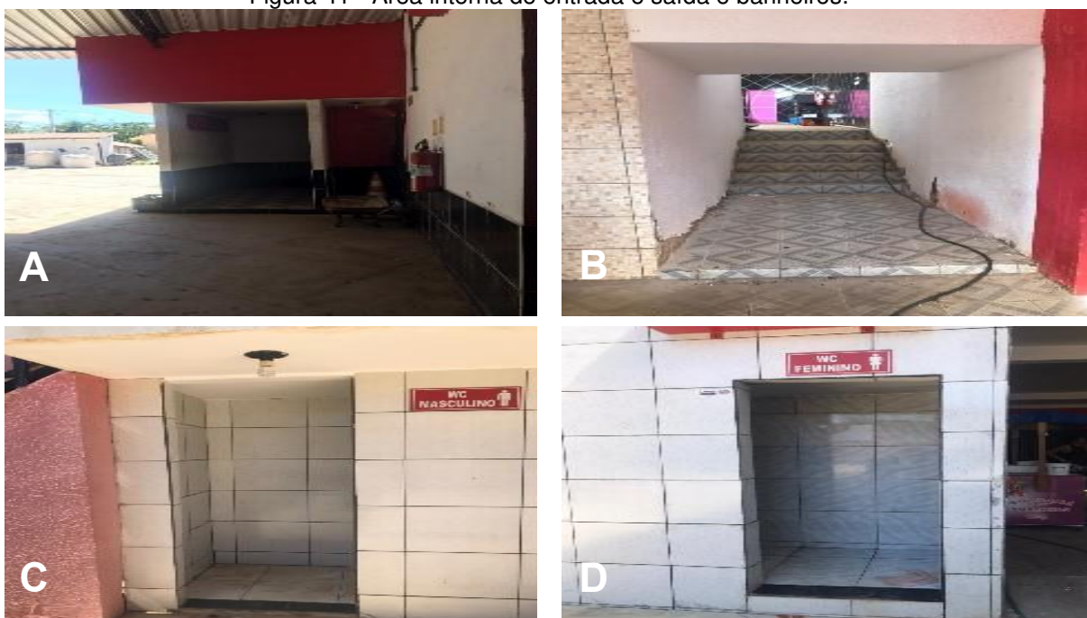
Figura 41 - Área interna de entrada e saída e banheiros.
