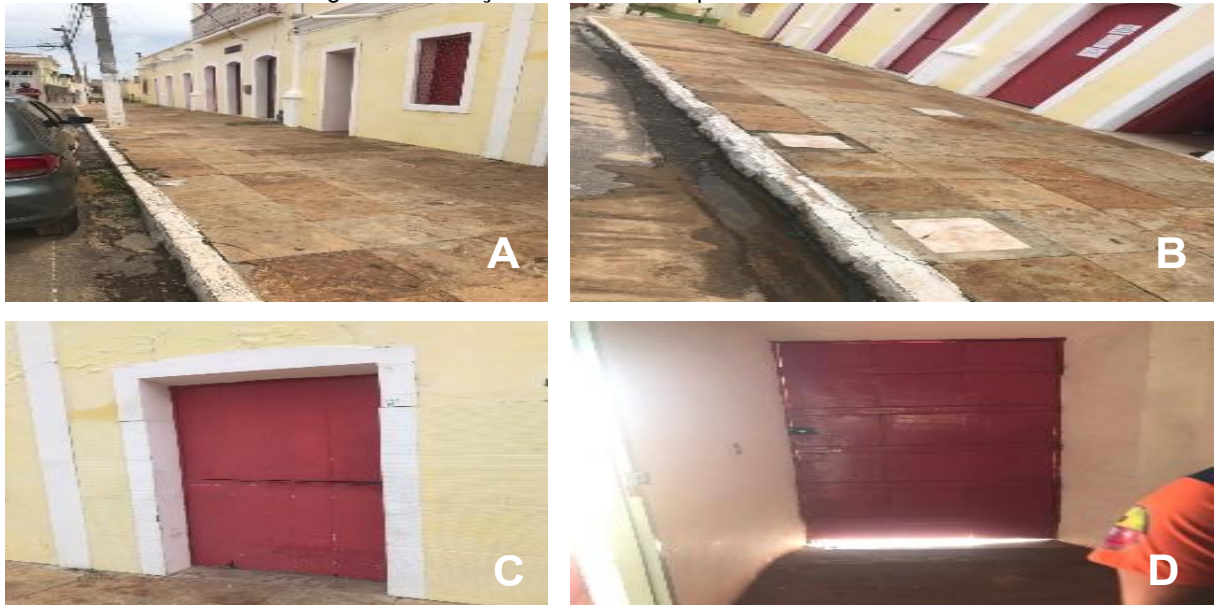
Figura 24 - Calçada de acesso e portas de entrada.
