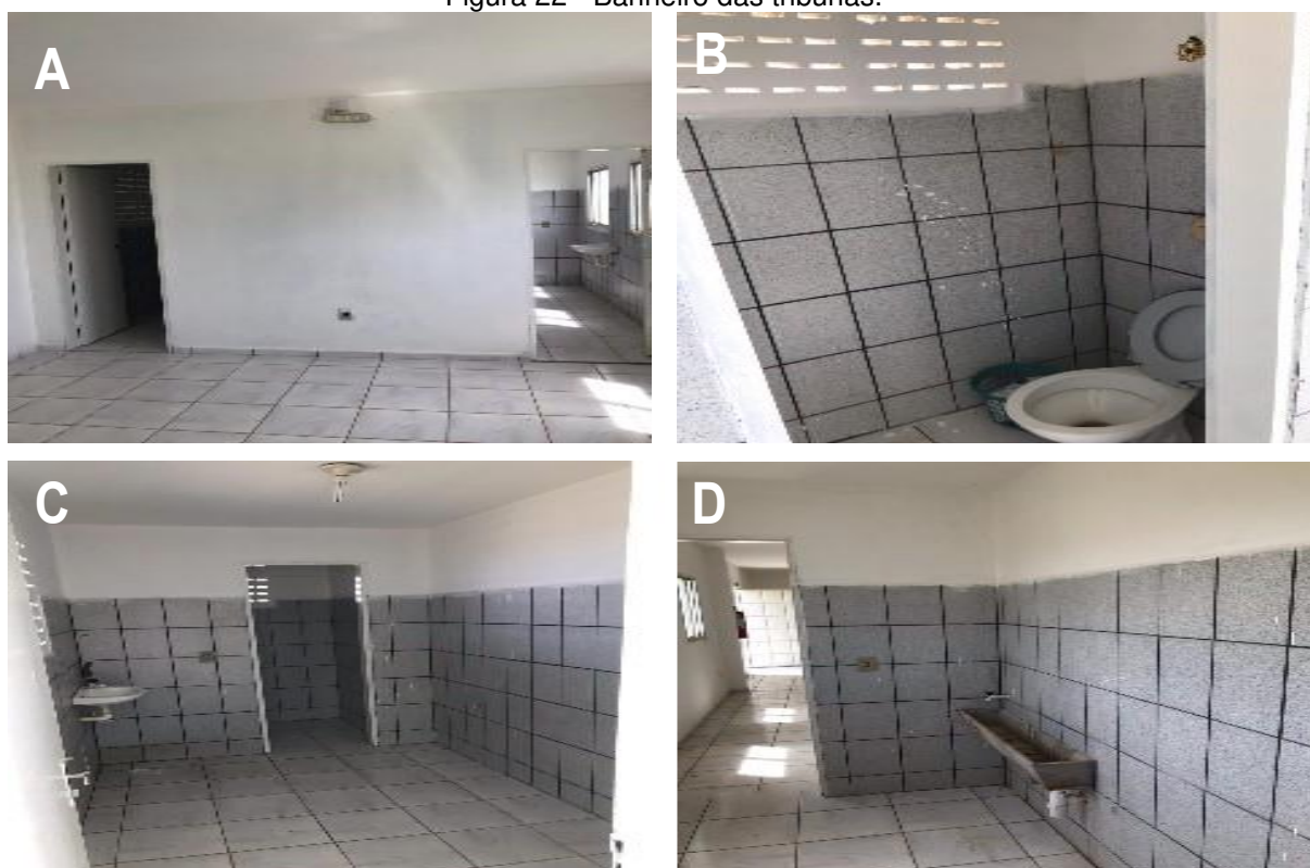
Figura 22 - Banheiro das tribunas.
