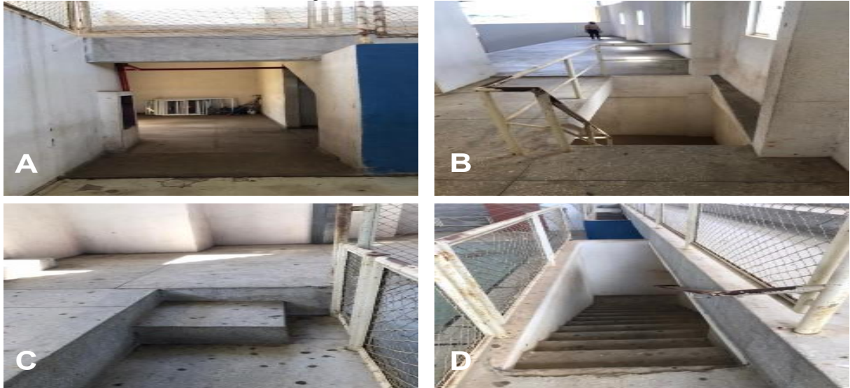
Figura 34 - Acesso as escadas.
