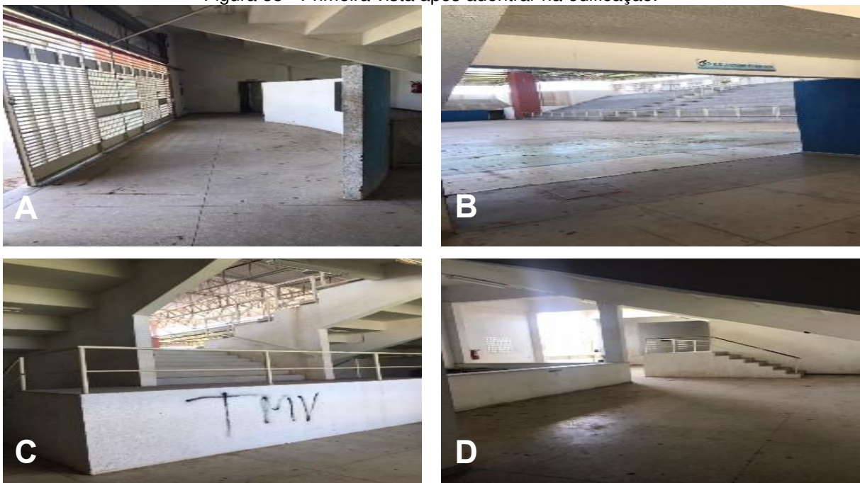
Figura 33 - Primeira vista após adentrar na edificação.
