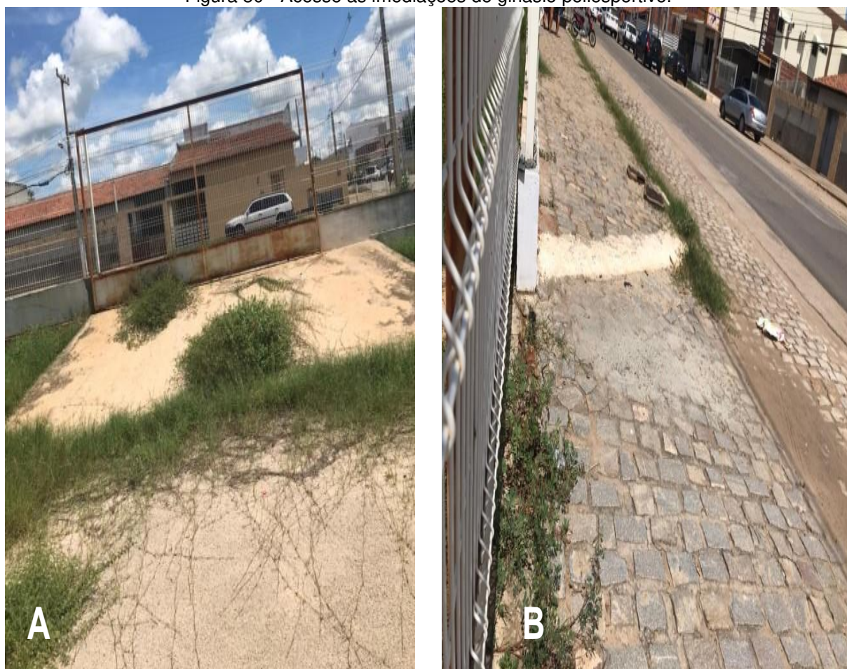
Figura 30 - Acesso as imediações do ginásio poliesportivo.
