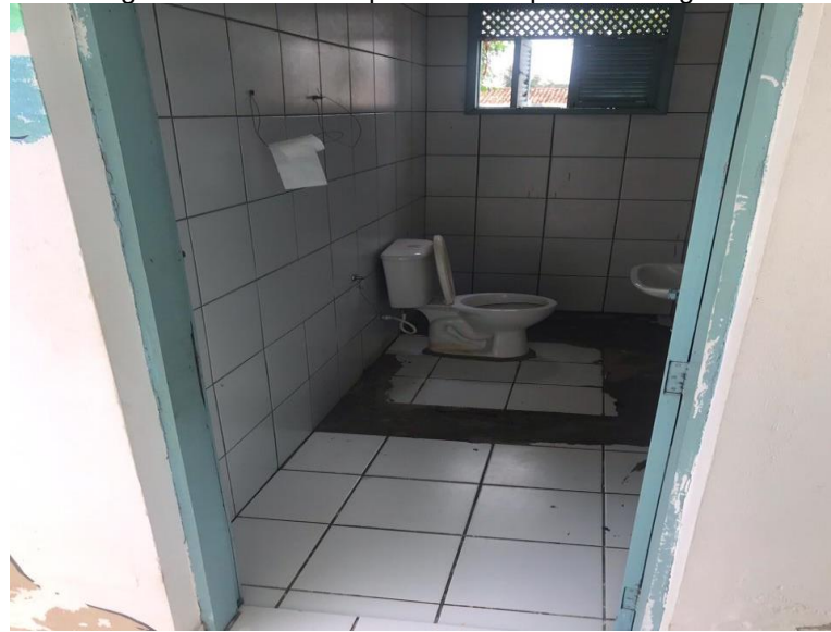
Figura 27 - Banheiro para uso do público em geral.
