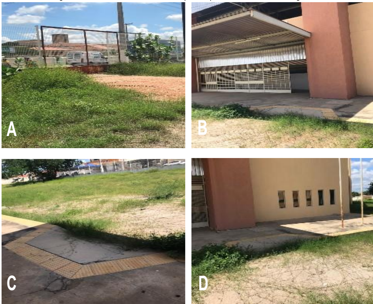
Figura 31 - Percurso entre a via e o portão para acesso interno do ginásio.
