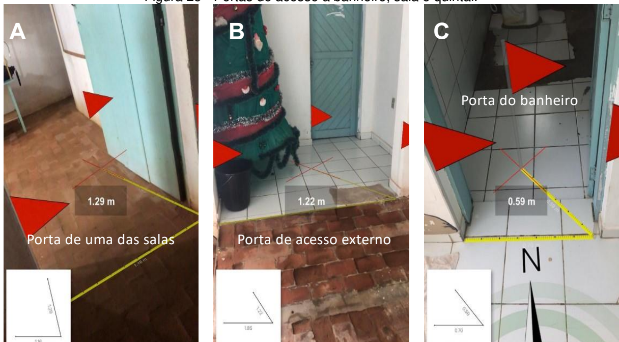
Figura 25 - Portas de acesso a banheiro, sala e quintal.
