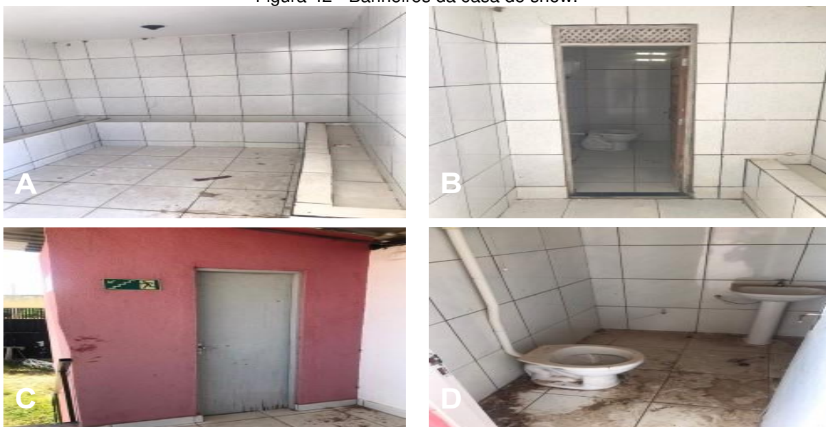
Figura 42 - Banheiros da casa de show.
