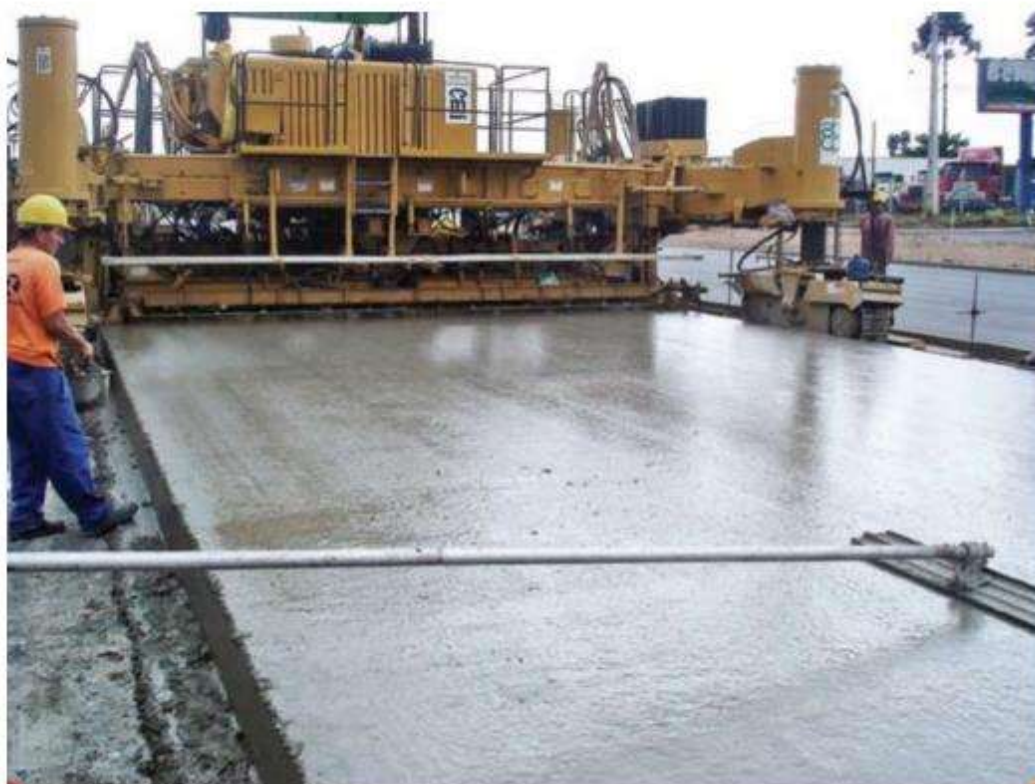
Figura 10: Execução de pavimento de concreto com equipamento de fôrma deslizante.
