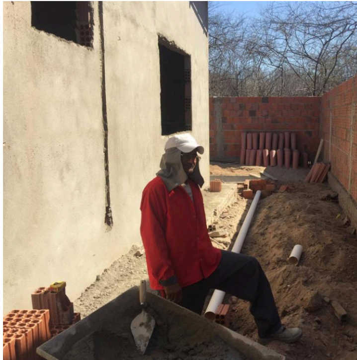
Figura 8: Trabalhadores no canteiro de obras.
