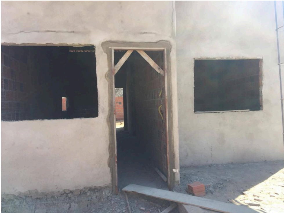
Figura 13: Tábua obstruindo a via de circulação.
