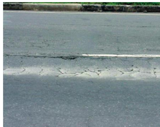
Figura 32 – Ex. 2 bombeamento em pavimento.
