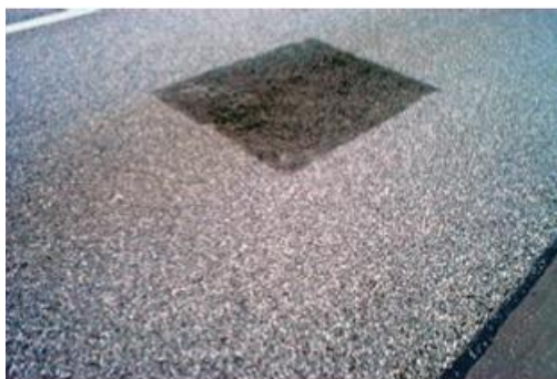
Figura 14 – Ex. 1 remendo.
