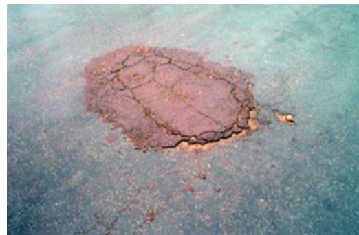
Figura 15 – Ex. 2 remendo superficial.
