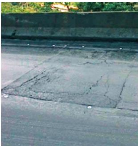
Figura 10 – Ex. 1 trinca de reflexão.
