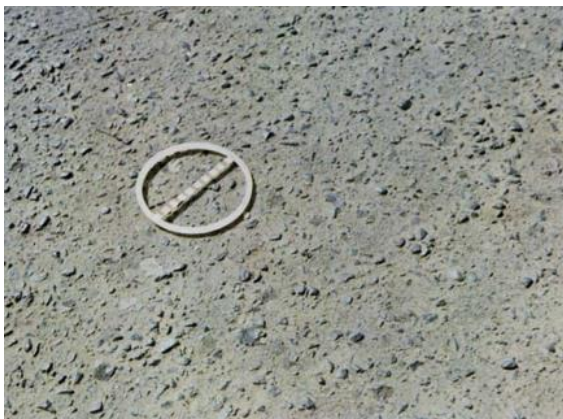
Figura 28 – Ex. 1 desgaste no pavimento.
