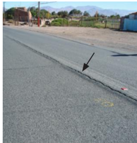
Figura 11 – Ex. 2 trinca de reflexão.
