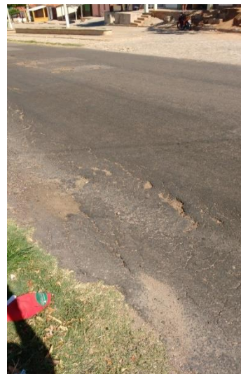
Figura 44 – Deformação permanente na seção 16.
