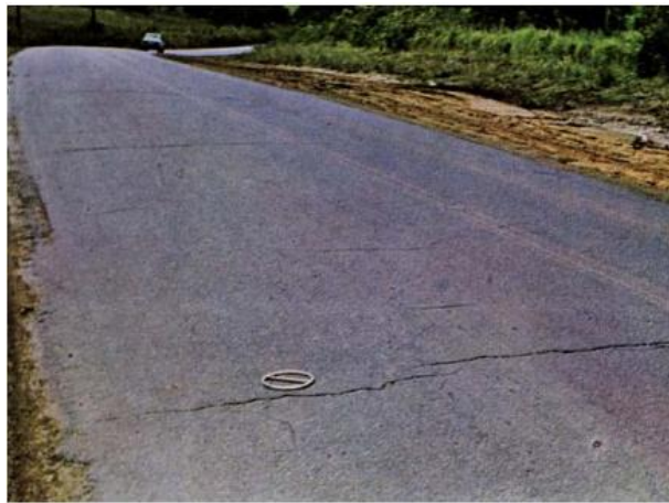
Figura 12 – Trinca transversal.
