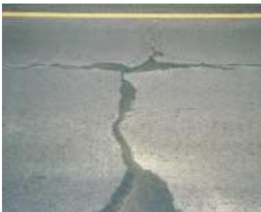
Figura 31 – Ex. 1 bombeamento em pavimento.
