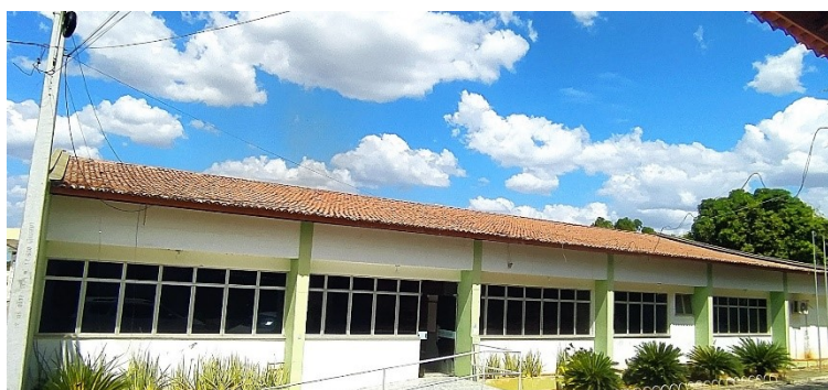
Figura 3: Entrada principal da edificação.
