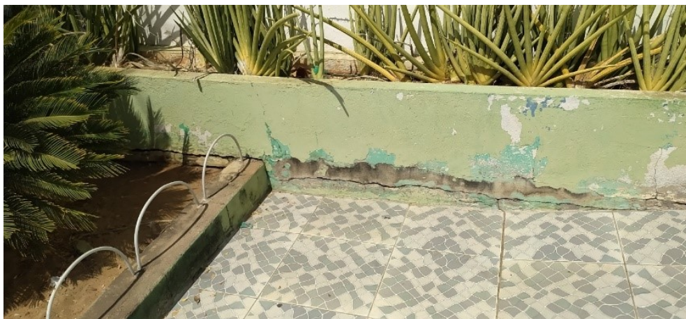
Figura 7: Fissura na rampa de acesso à entrada do centro administrativo
