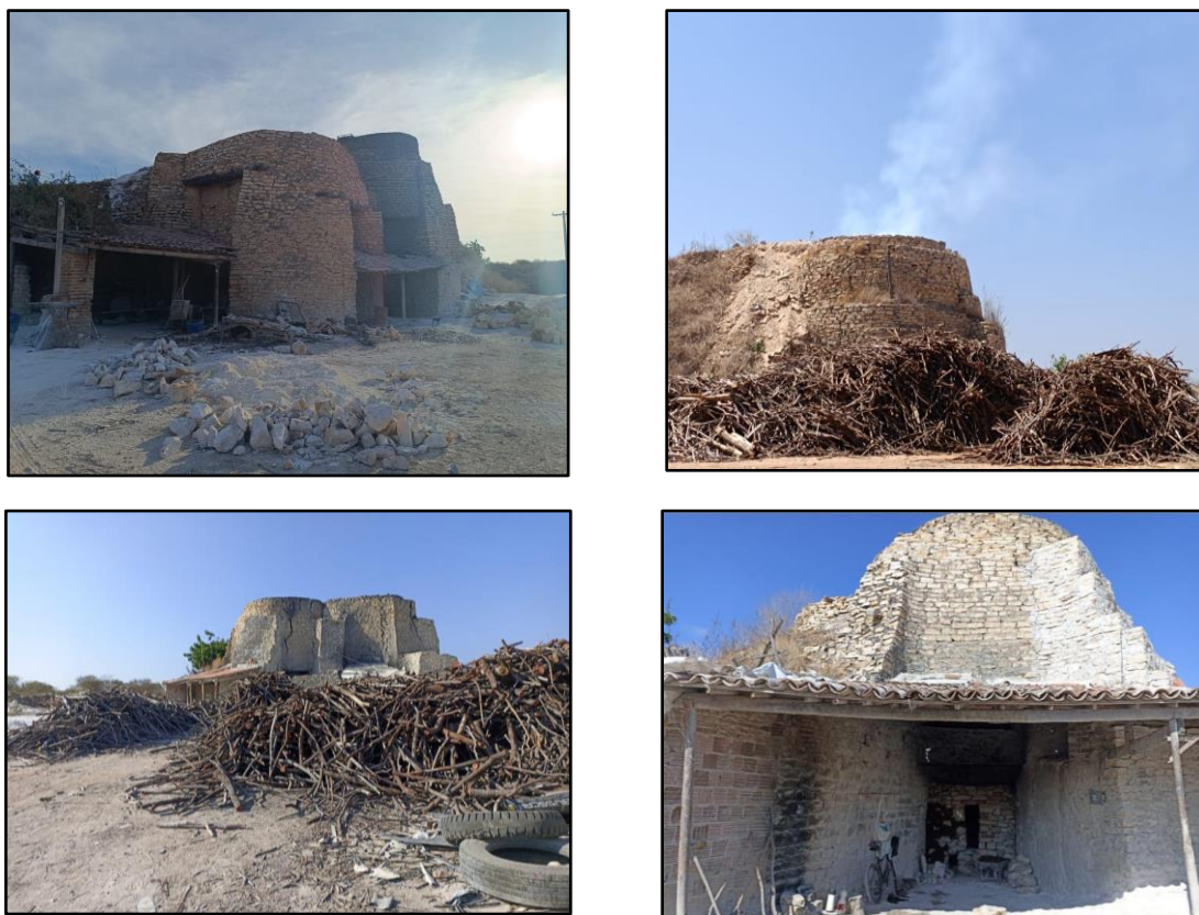
Figura 16: fornos de cal de construção artesanal em Governador Dix-sept Rosado
