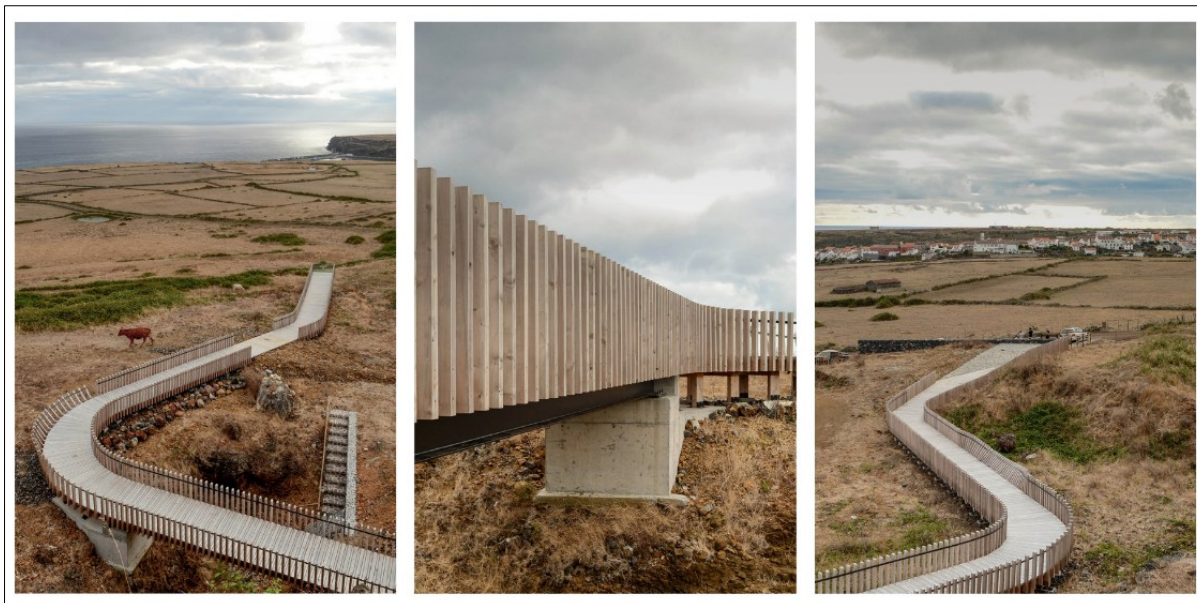
Figura 9 – Imagens Aéreas e à Altura dos Olhos da Passarela e Estruturas
