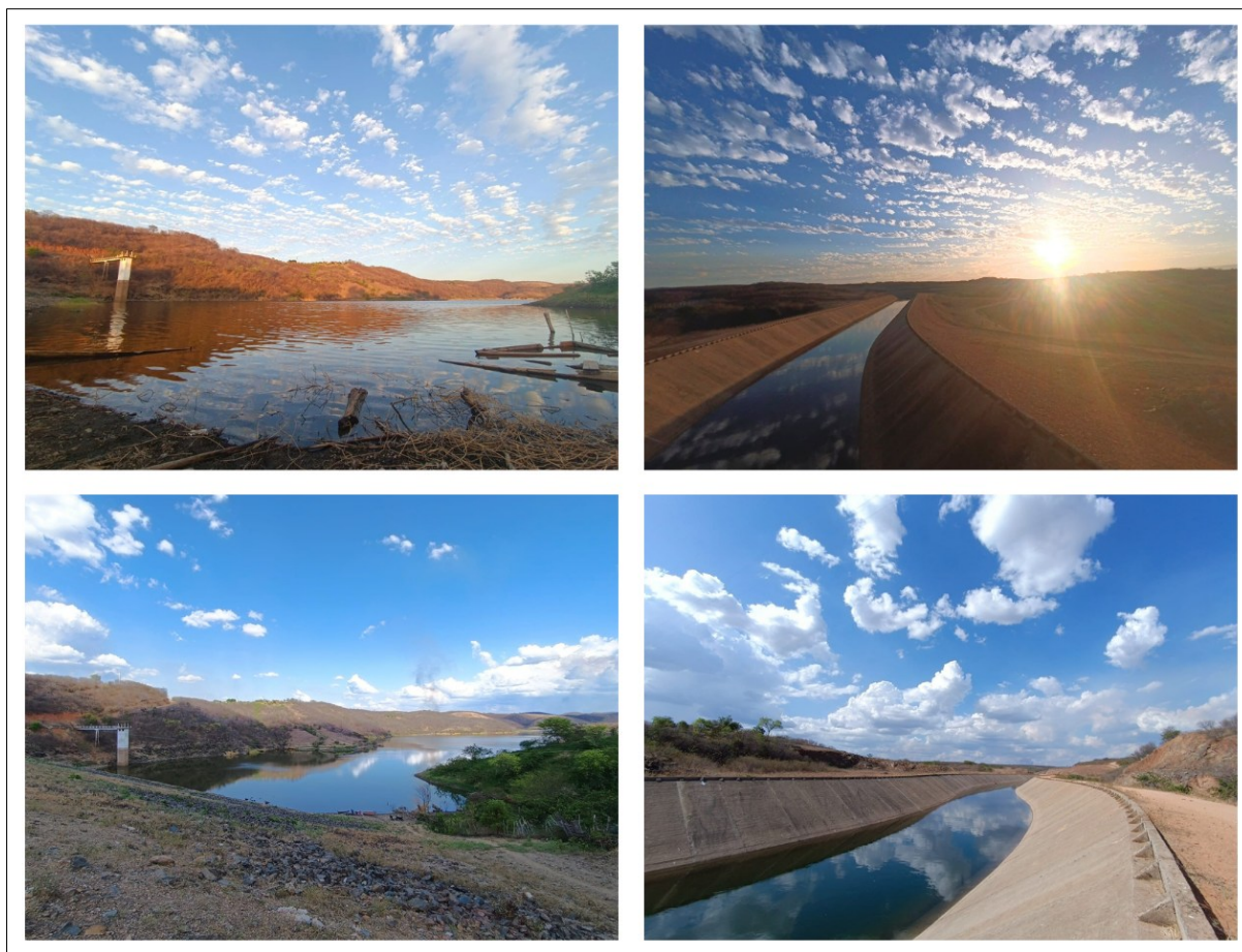
Figura 52 – Fotografias do Reservatório da Quixabinha e do Canal da Transposição do Rio São Francisco na Cidade de Mauriti/CE
