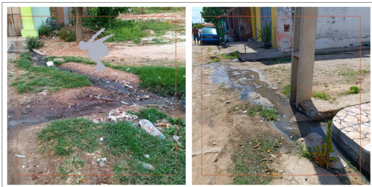
Figura 40 – Ausência de Saneamento
