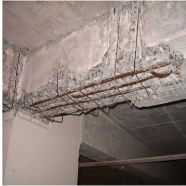
Figura 4– Desagregação
