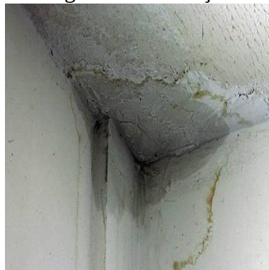
Figura 8– Infiltração
