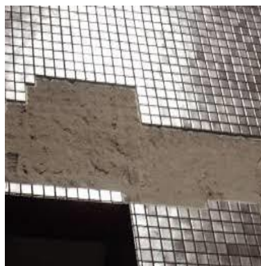
Figura 3 – Destacamento
