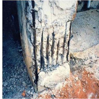
Figura 5– Corrosão
