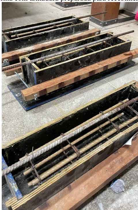
Figura 11: Fôrma com armadura preparada para recebimento do concreto.
