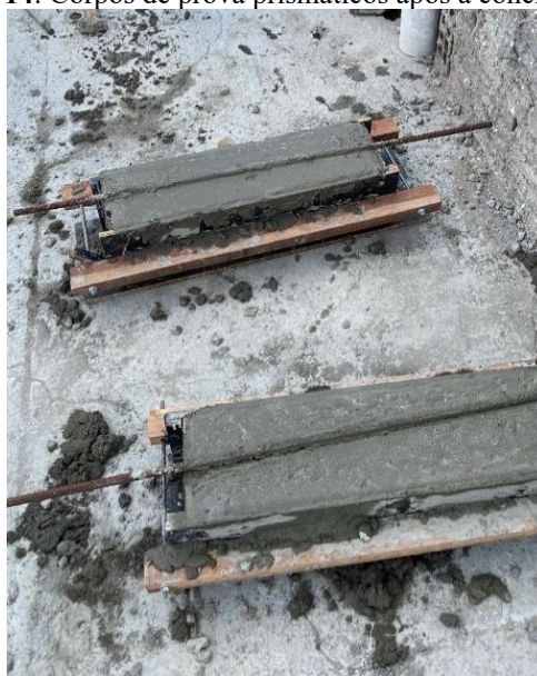
Figura 14: Corpos de prova prismáticos após a concretagem.
