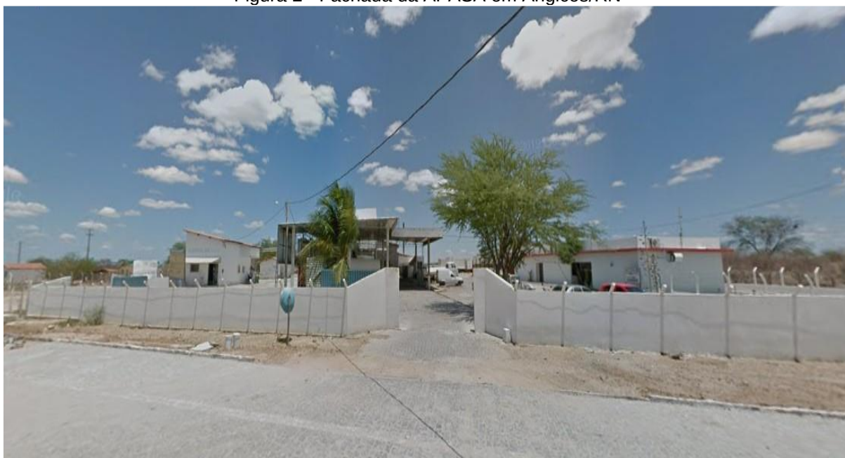
Figura 2 - Fachada da APASA em Angicos/RN
