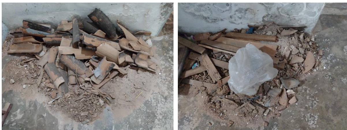
Figura 24: RCC gerados em reforma de um telhado (Obra 15)
