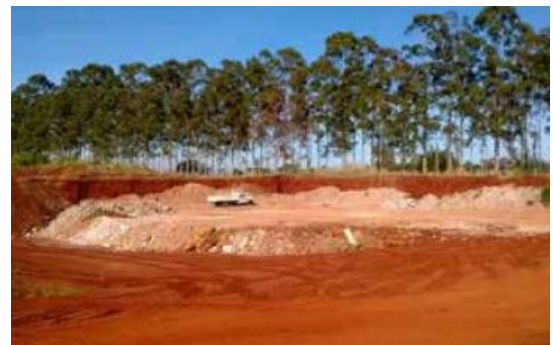
Figura 52: Aterro de inertes (RCC classe A) em Limeira/SP
