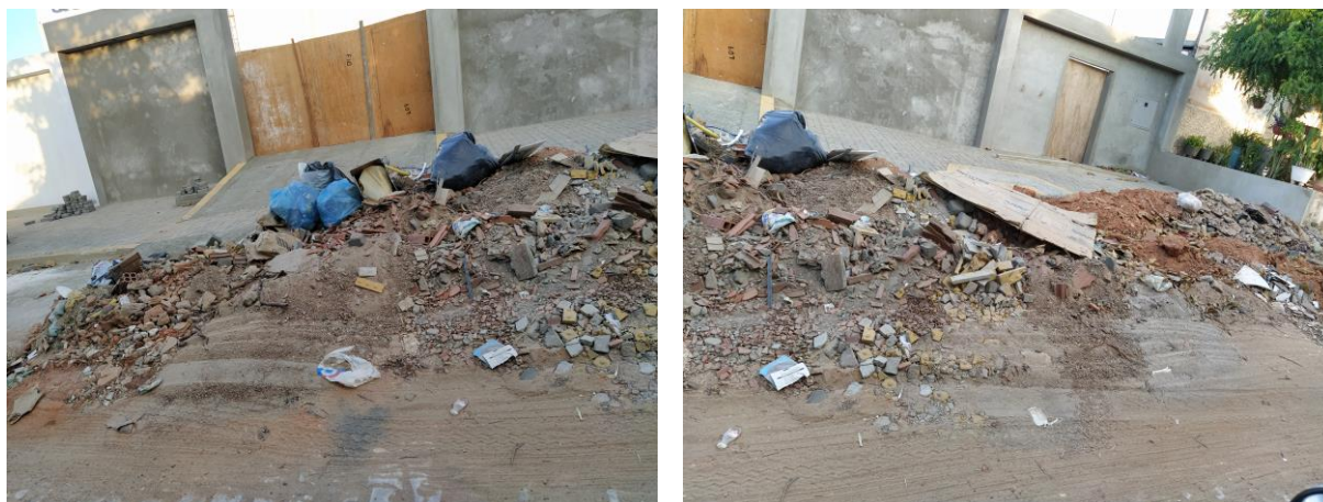
Figura 5: RCC gerados em uma reforma de fachada (Obra 1)
