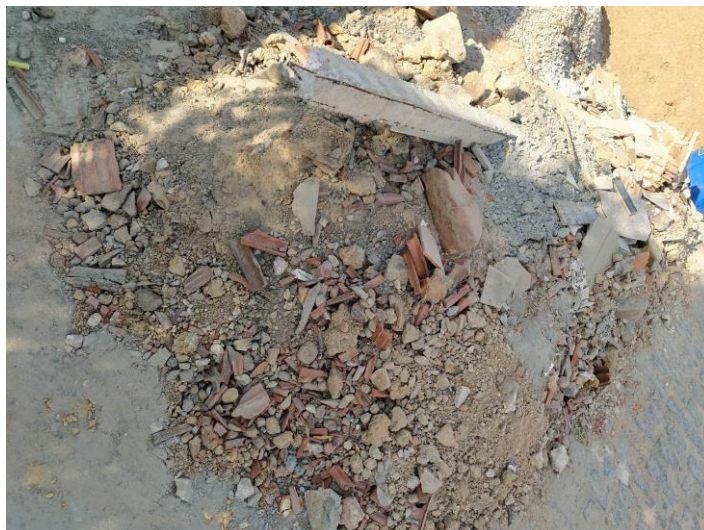
Figura 16: RCC gerados em reforma de um quarto (Obra 9)
