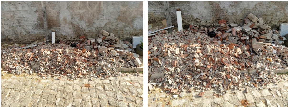
Figura 22: RCC gerados em reforma de uma cozinha (Obra 13)
