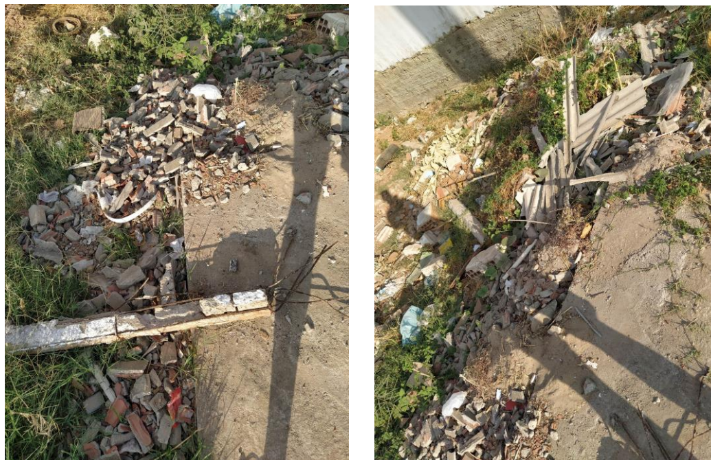
Figura 13: RCC gerados em reforma de uma área de serviço (Obra 7)
