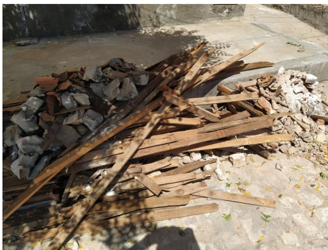
Figura 20: RCC gerados em uma reforma de cobertura (Obra 11)
