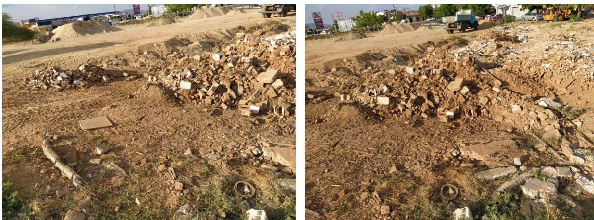
Figura 12: RCC gerados em demolição (Obra 6)
