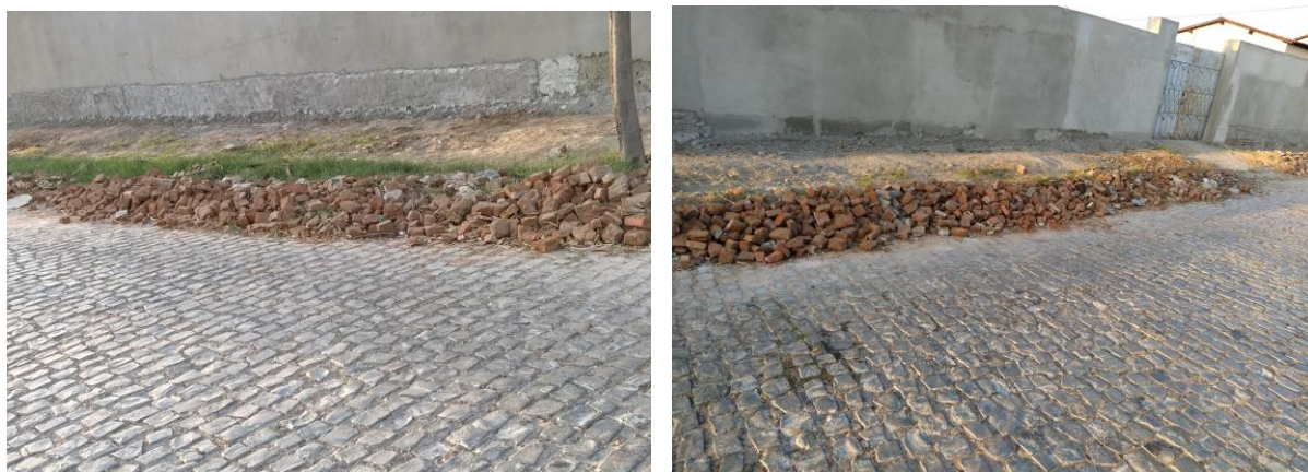
Figura 9: RCC oriundos de demolição dispostos em via pública (Obra 4)
