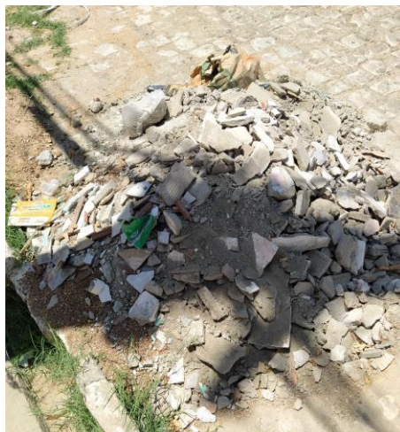
Figura 23: RCC gerados em reforma de uma cozinha (Obra 14)
