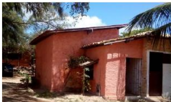
Figura 16 – Casa de pau-a-pique pintada com geotinta em Barra de Santa Rosa.
