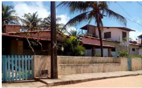
Figura 15 – Paredes externas e testada do muro pintadas com geotinta.
