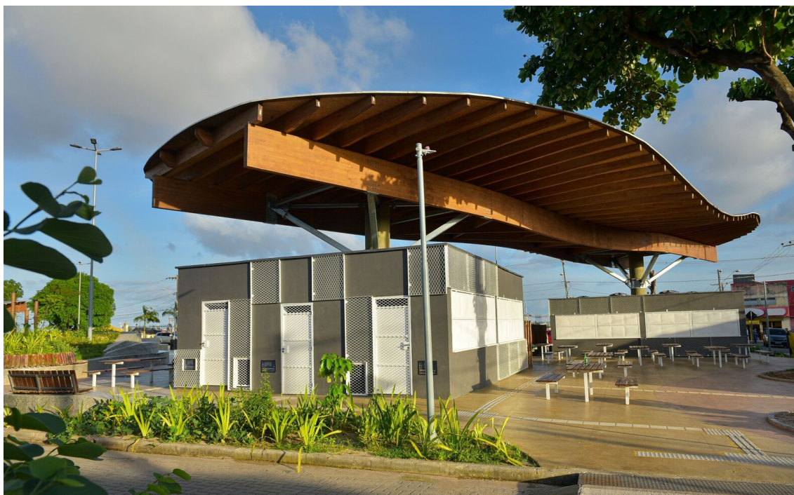
Figura 39 – Cobertura em madeira colada dos quiosques da Praça da Saudade
