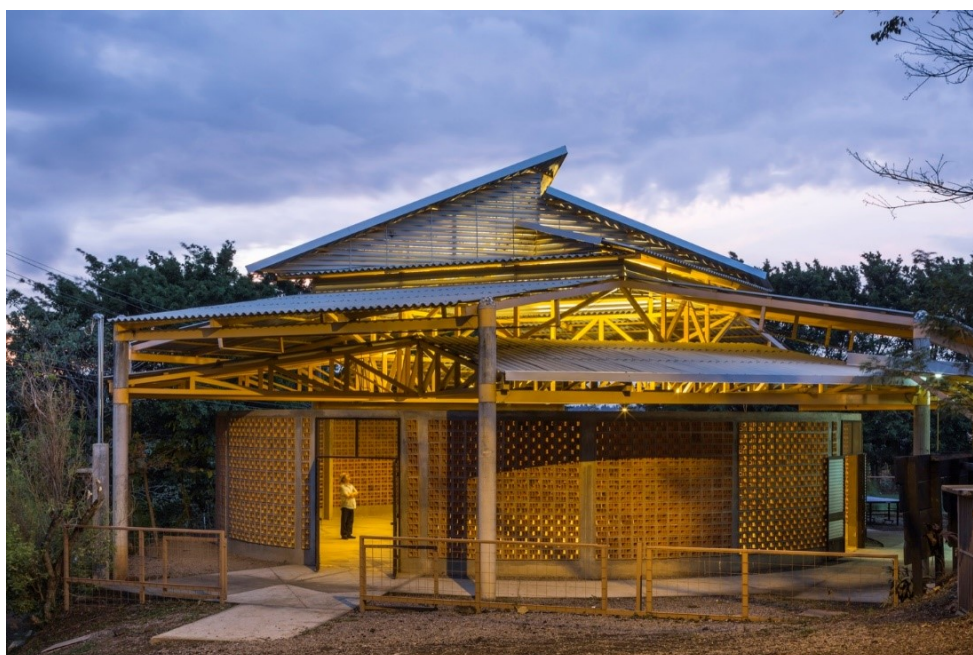
Figura 30 – Vista exterior do Centro Comunitário de El Rodeo de Mora
