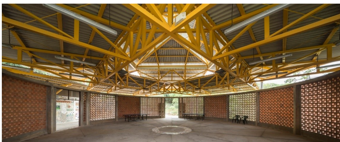
Figura 34 – Vista interna da cobertura do Centro Comunitário de El Rodeo de Mora
