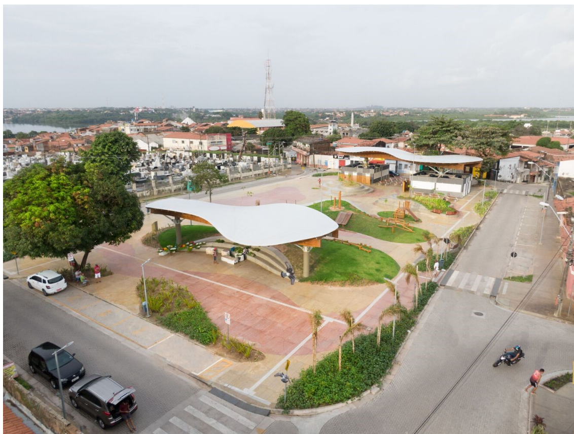
Figura 36 – Vista geral da Praça da Saudade
