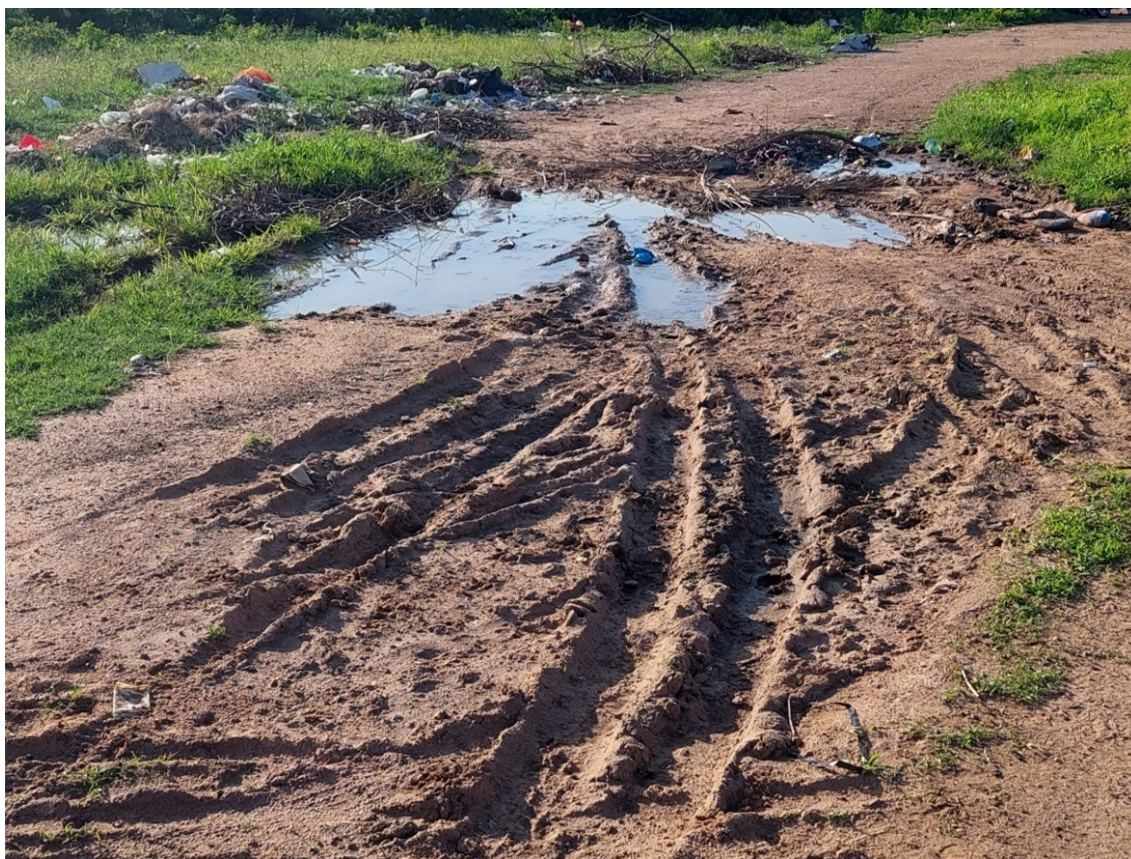
Figura 13 – Exemplo de esgoto a céu aberto na comunidade cigana
