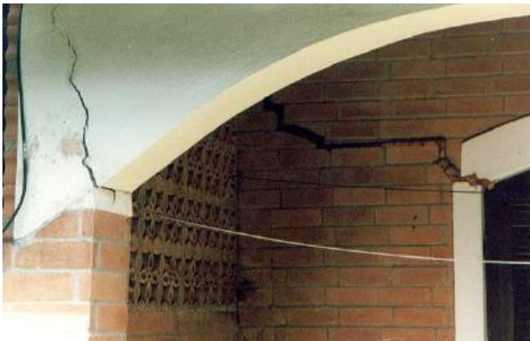
Figura 8 - Rachaduras
