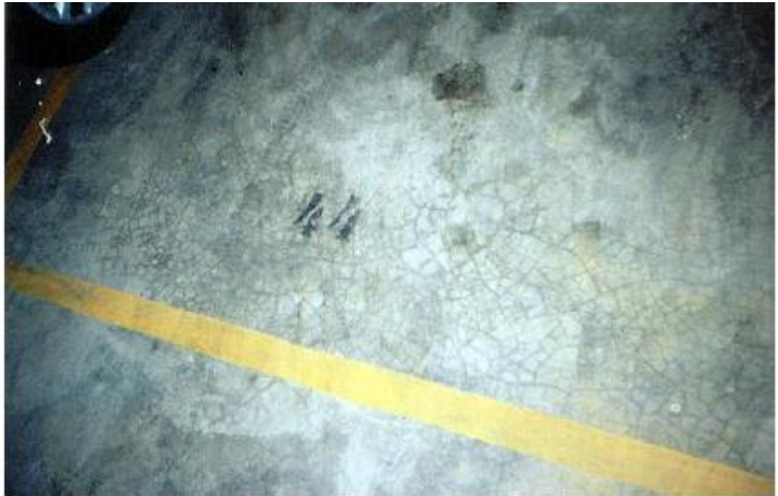
Figura 6 - Fissuras
