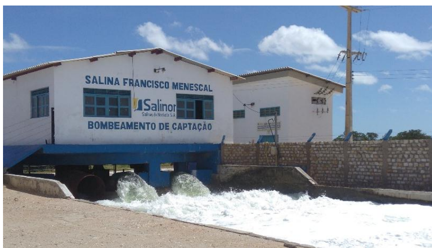
Figura 4: Bombeamento de captação de água da salina Francisco Menescal – Salinor. Cada bomba possui uma capacidade de bombeamento de 2500 l/min.
