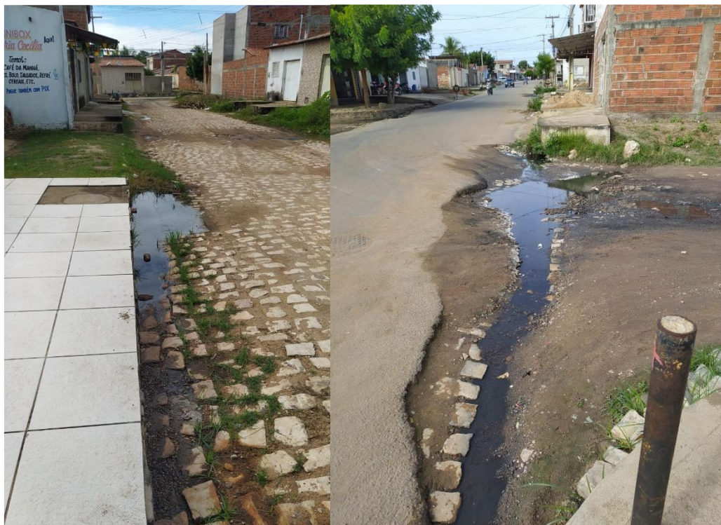
Figura 12. Lançamento de esgoto em via pública no bairro Santo Antônio, Mossoró/RN.
