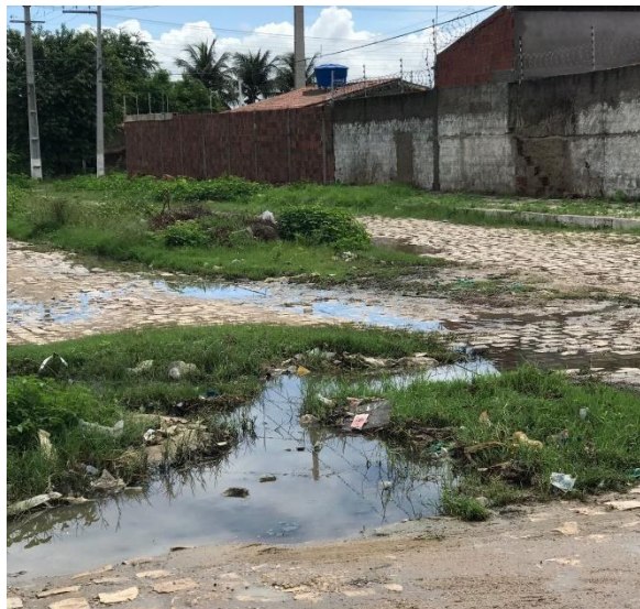
Figura 11. Acumulação de esgoto a céu aberto no bairro Barrocas, Mossoró/RN.
