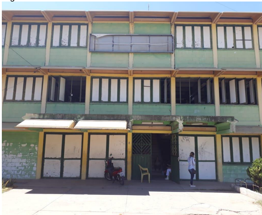
Figura 13: Fachada da Escola Estadual Alvani de Freitas Dias
