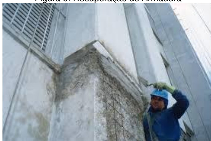
Figura 9: Recuperação de Armadura
