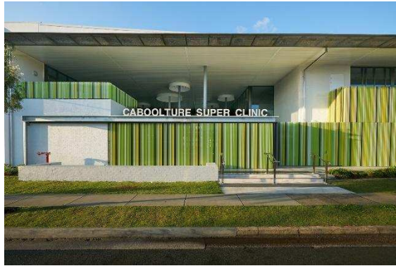
Figura 33: Painéis na fachada da clínica
