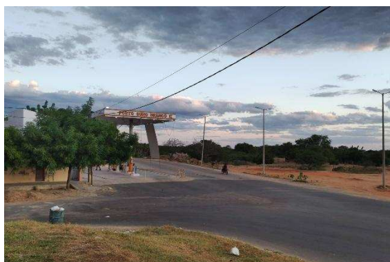
Figura 50: Posto de Combustível, Ouro Branco II
