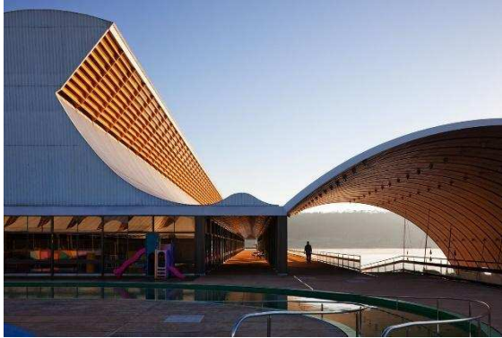
Figura 9: Sheds presente no Hospital
