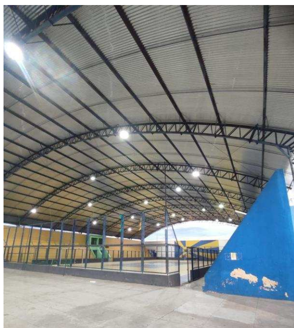
Figura 55: Cobertura do Ginásio Lafaiete Anselmo
