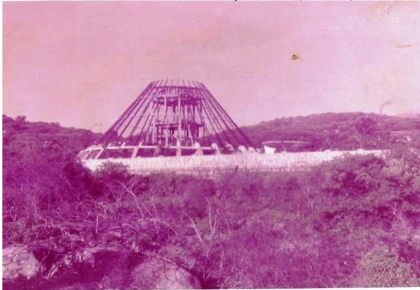
Foto 18: Detalhe da construção da capela superior
