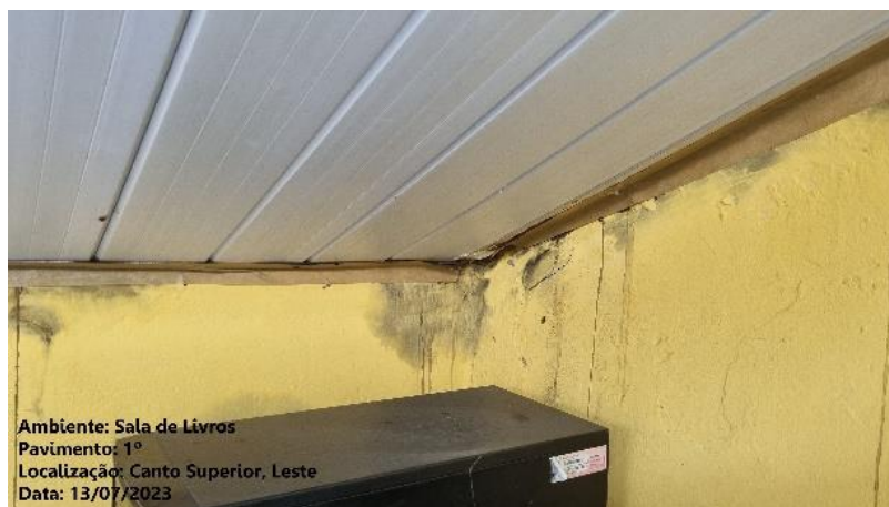
Figura 22 - Imagem de bolor na parede sala de livros.
