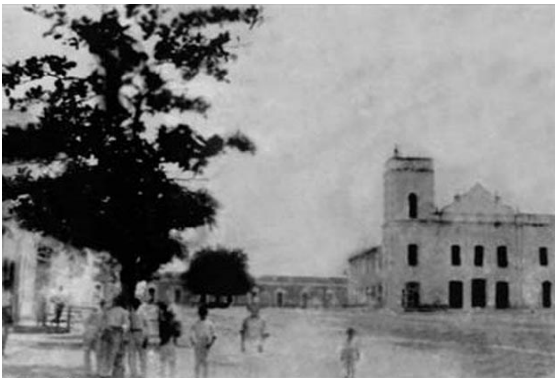
Imagem 1: Igreja de Santa Luzia durante a construção de sua primeira torre
