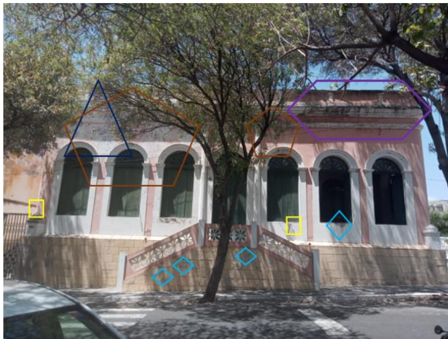
Figura 13 - Mapeamento das manifestações patológicas na fachada frontal
