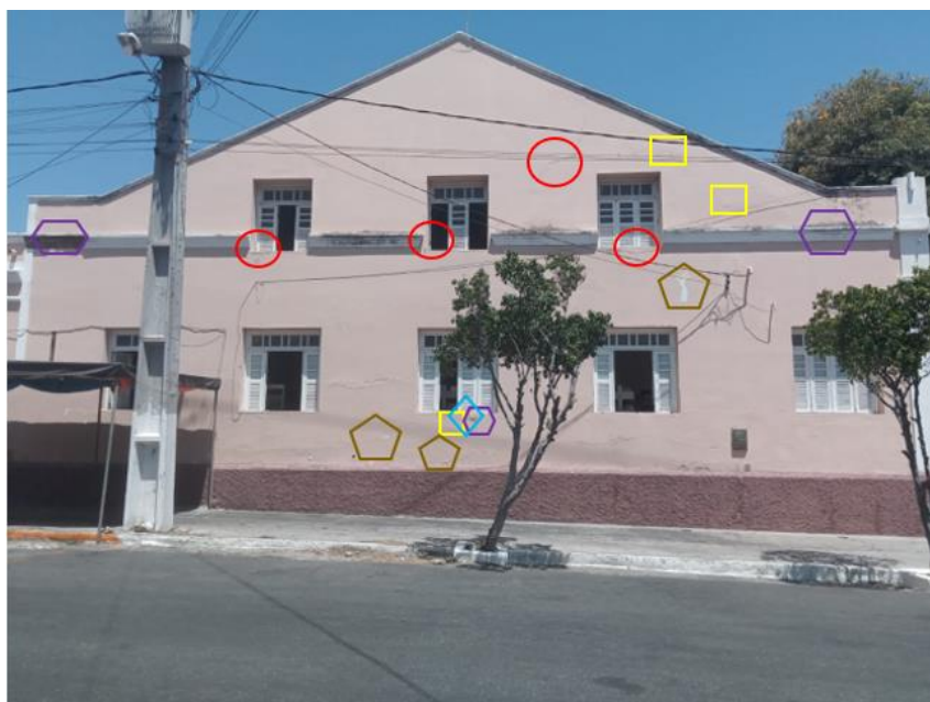
Figura 17 - Mapeamento das manifestações patológicas na fachada lateral esquerda da Biblioteca
