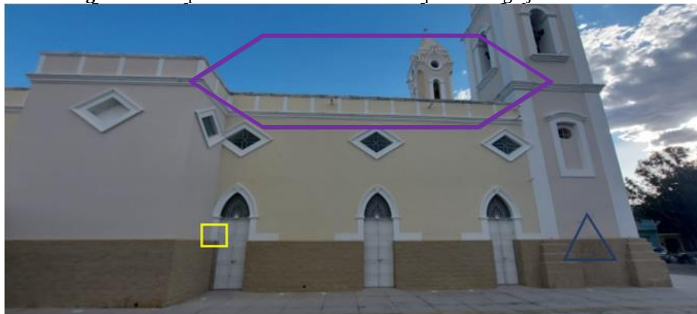
Figura 10 - Mapeamento da fachada lateral esquerda da igreja de Sant'Ana.
