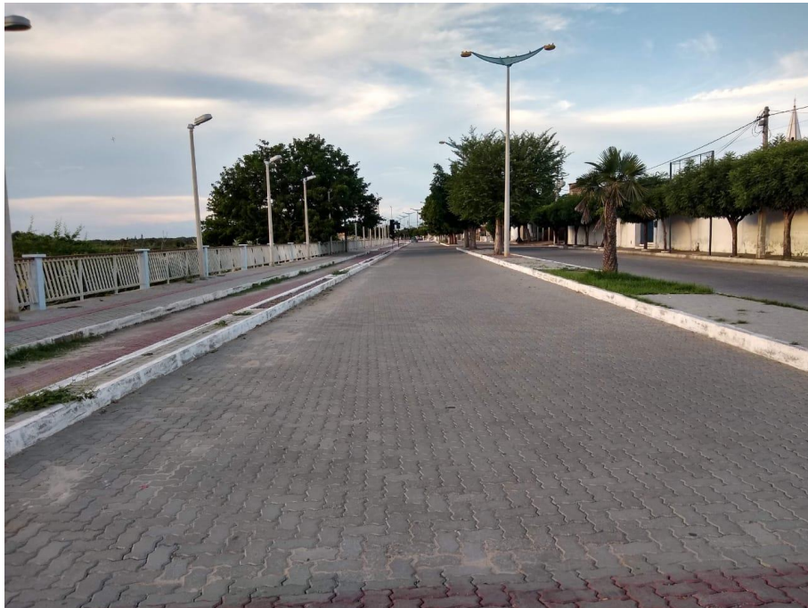
Figura 33: Revestimento da via em blocos de concreto intertravados
