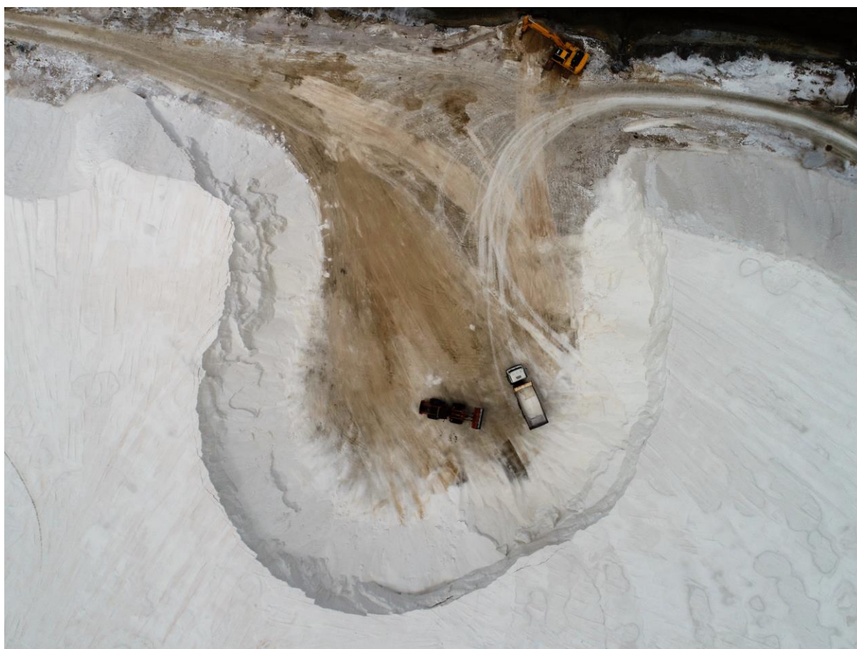
Figura 14 - Carregamento de caminhão para saída/pesagem
